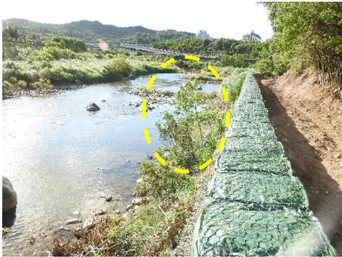
6. 靠近山壁建議不做溪溝，可於涵管處使用土袋包或石頭(混凝土)乾砌，勿再使用過多的人工建物。
