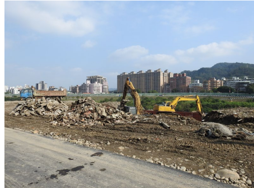
109/01/21 施工中(垃圾分類)
