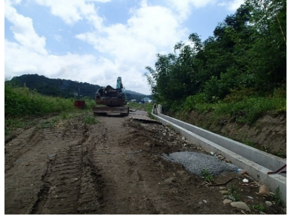
前期工程施工中防汛道路
