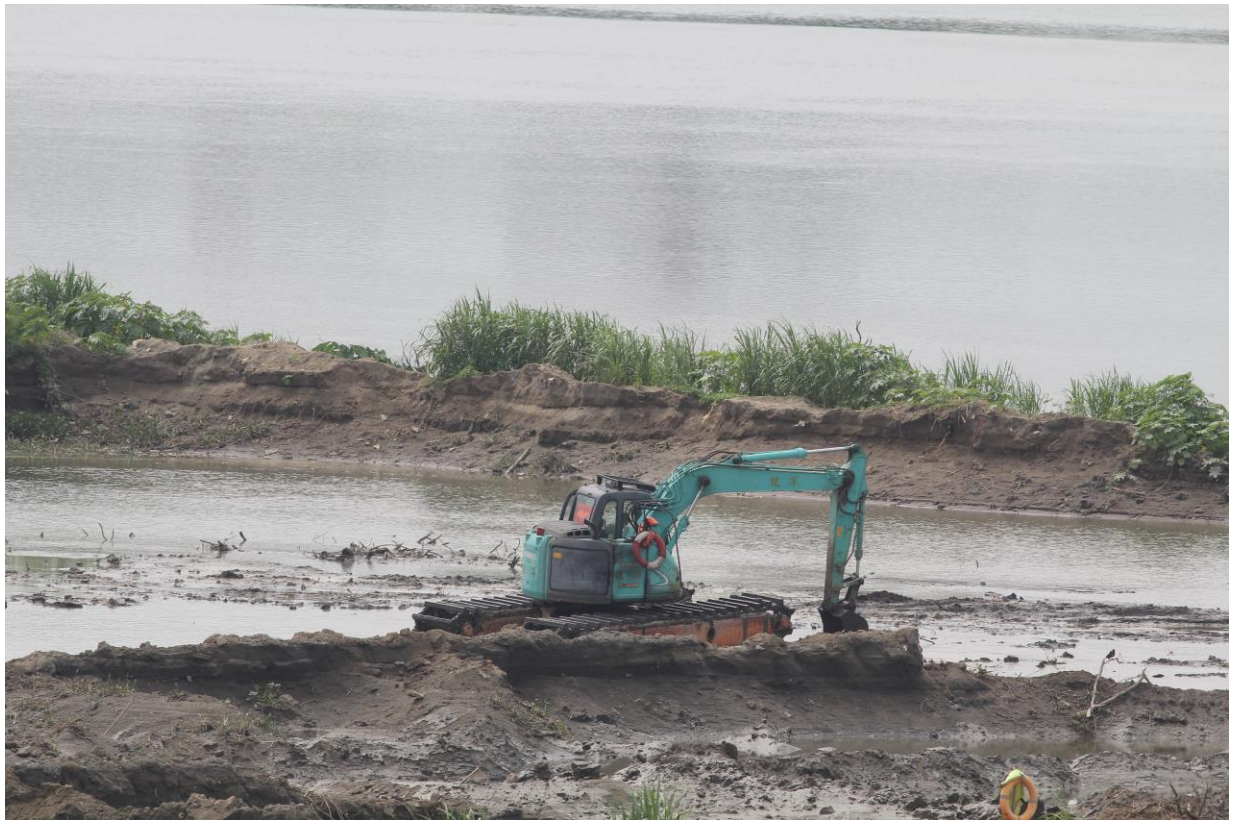
圖 3-3 二重疏洪道入口段現地狀況
