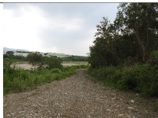
110/08/03 前期施工便道
