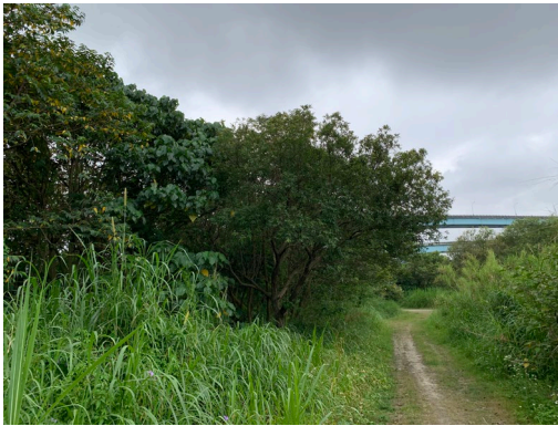
110/04/23 右岸施工便道
