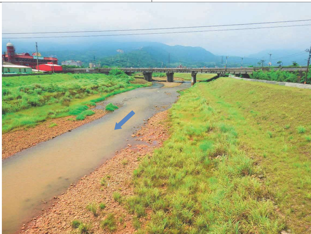
110/05/14 溪水因上游工程混濁
