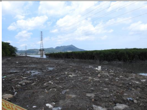
110/08/12 施工便道復原
