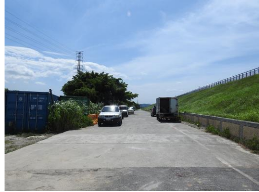
110/06/18 施工便道利用既有堤外便道
