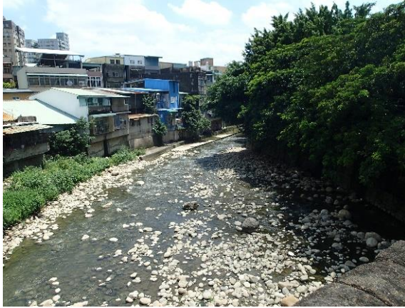
右岸水泥護岸、茄冬樹 (108/8/22)
