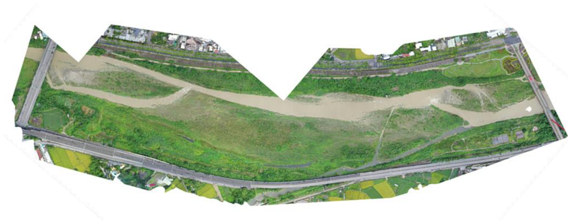
圖 14 後龍溪內麻堤防改善工程施工前空拍影像(110/06/21)
