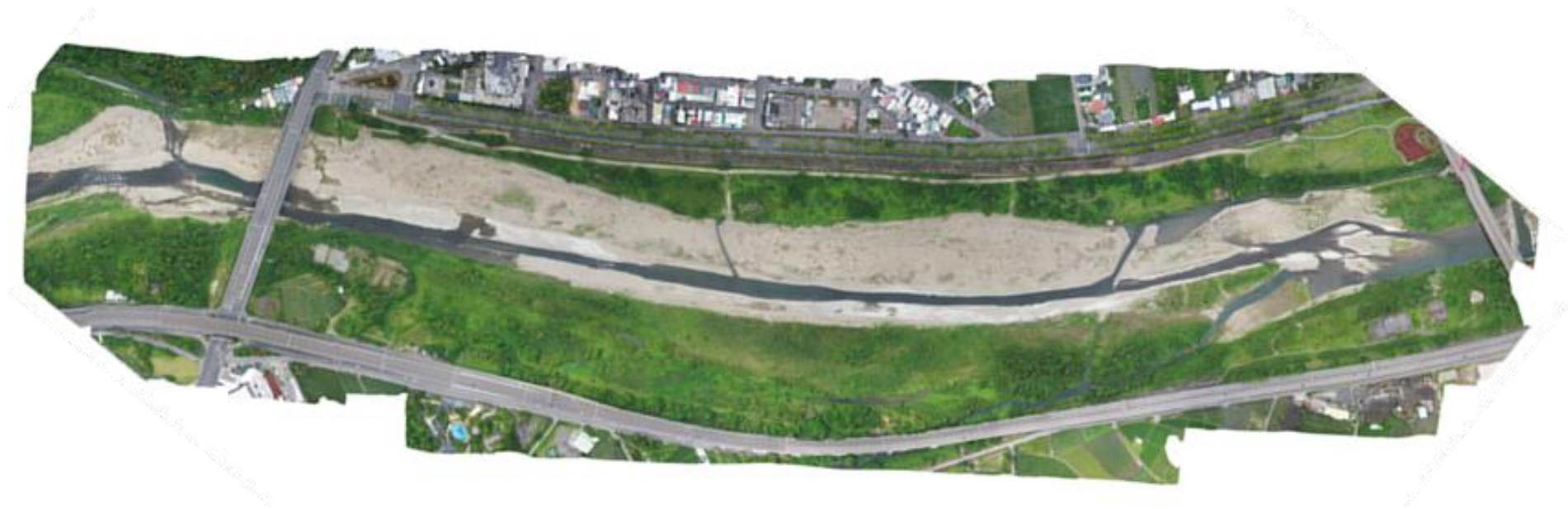
圖 15 後龍溪內麻堤防改善工程竣工後空拍影像(111/11/04)
