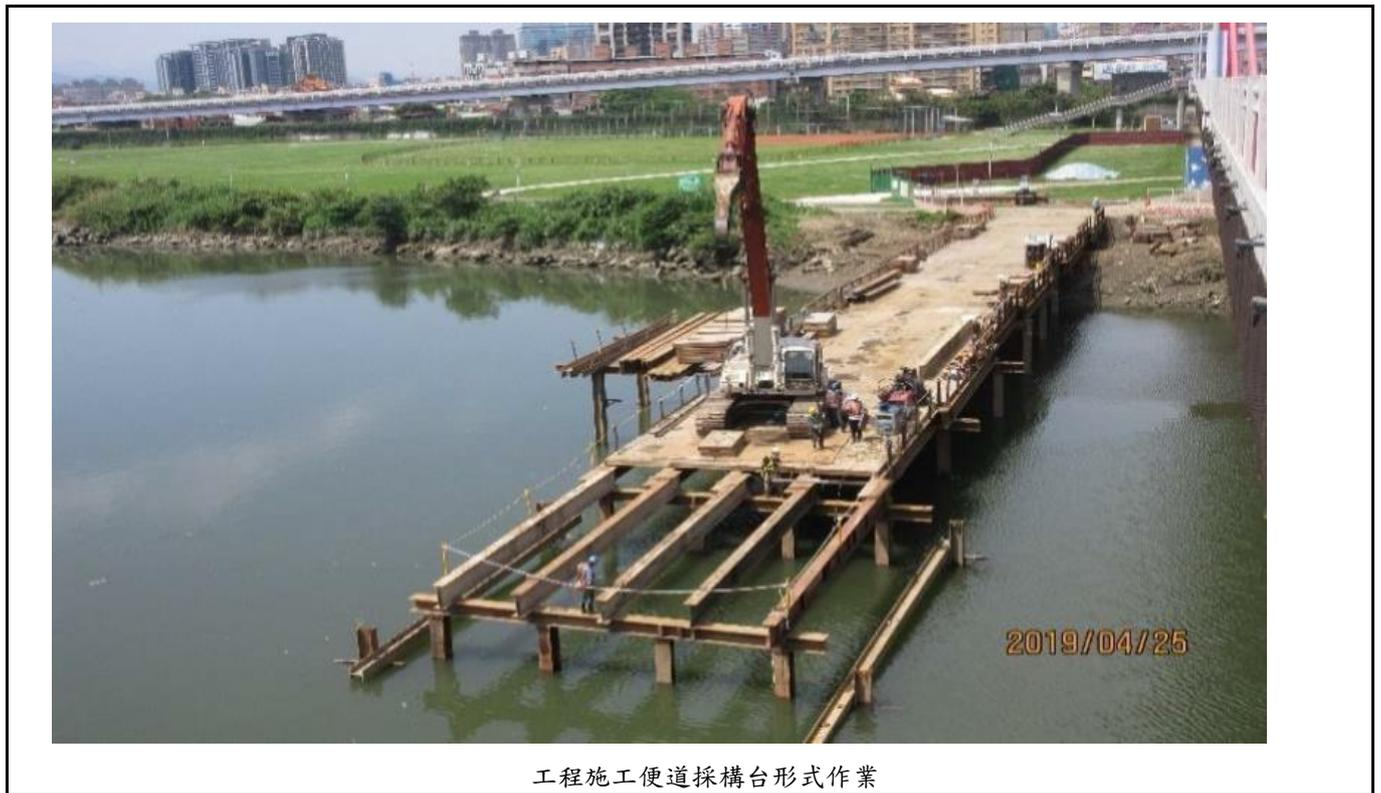
工程施工便道採構台形式作業
