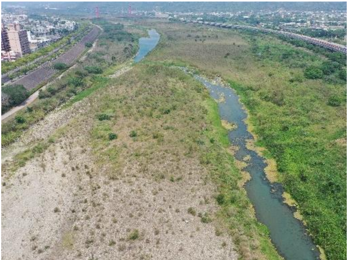
圖 17 後龍溪內麻堤防改善工程空拍正射影像 B(施工前)(110/04/16)
