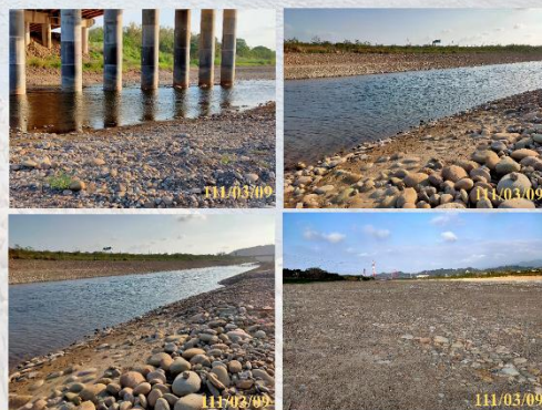
圖3 後龍溪內麻堤防改善工程生態改善措施執行情形
