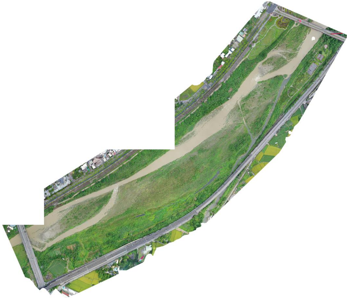
圖 18 後龍溪內麻堤防改善工程空拍正射影像(施工前)(110/06/21)
