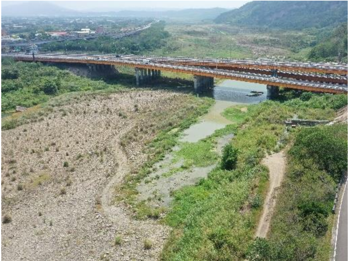
圖 16 後龍溪內麻堤防改善工程空拍影像 A(施工前)(110/04/16)
