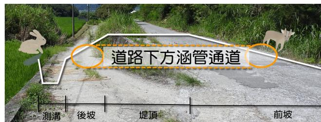
側溝版橋、順水流向的道路下方通道
