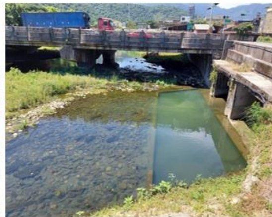
排放口設置沉砂池及植生改善水質
