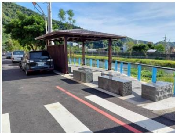
遷移電線拆除招牌，營造入口意象
