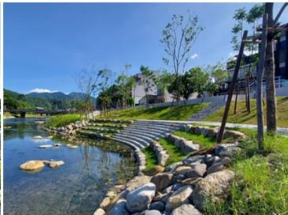
打破阻隔，建構安全友善河濱休閒步道
