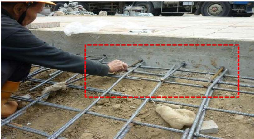
鋼筋網鋪設下方未加墊塊
