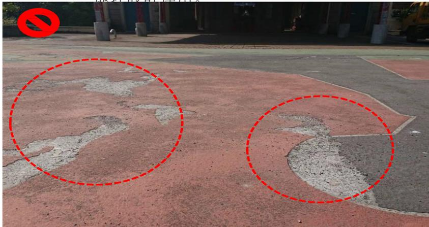
規劃設計不透水硬鋪面設備卻未確認是否有地下管線設施存在。
