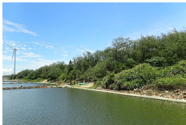
b.預定工區堤前現況
