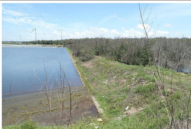
c.預定工區南端現況，堤前仍為魚塭。
