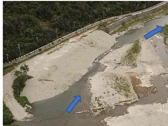
左岸河道於 110 年曾施作搶災搶險工程，設置寬二十數公尺；右岸則是施作河道整理工程，導正流心。
