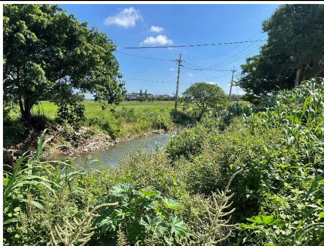
位置或樁號： 日期： 110/8/16 說明： 高草叢護岸
