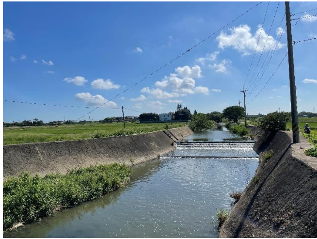
位置或樁號： 日期： 110/8/16 說明： 靠近五福橋的河段有水泥護岸
