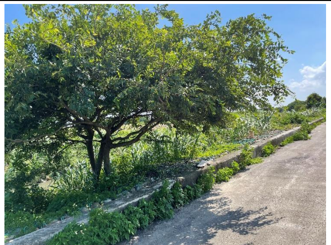
位置或樁號： 日期： 110/8/16 說明： 之前做過石籠護岸保護
