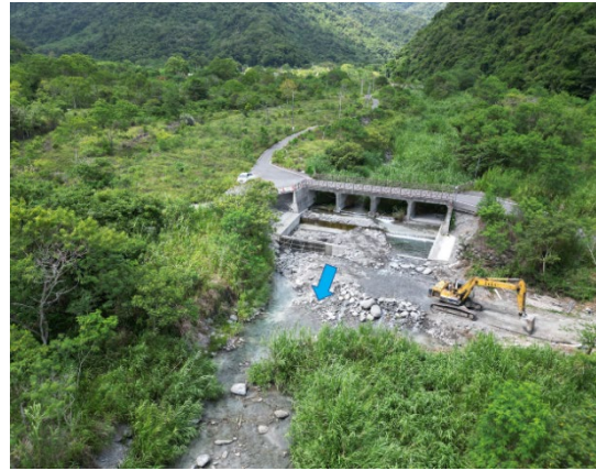
鄰近卓溪左岸堤防河段目前有攔砂壩工程進行中。
