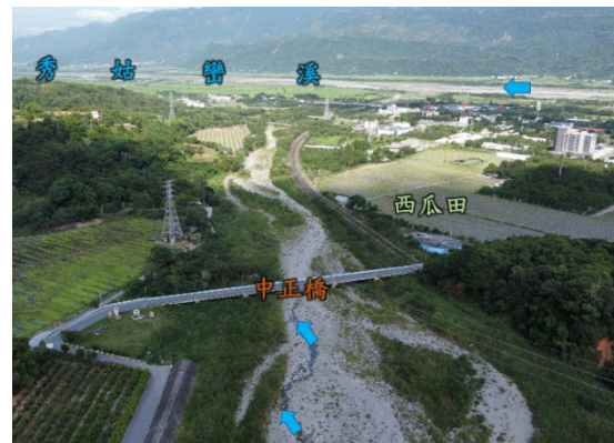
卓溪河床淤積嚴重，現勘時發現水流至中正橋發生斷流，中正橋以下游無水。
