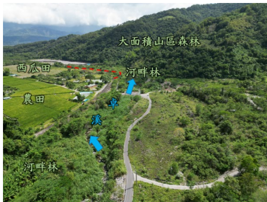
工區範圍右側為大面積山區森林及西瓜田；左側則有部落、農田、西瓜田及河畔林等棲地類型。
