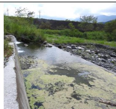
辮狀河流路靠近匯流口處(左圖)出現嚴重藻華，固床工上(右圖)也有藻華現象。
