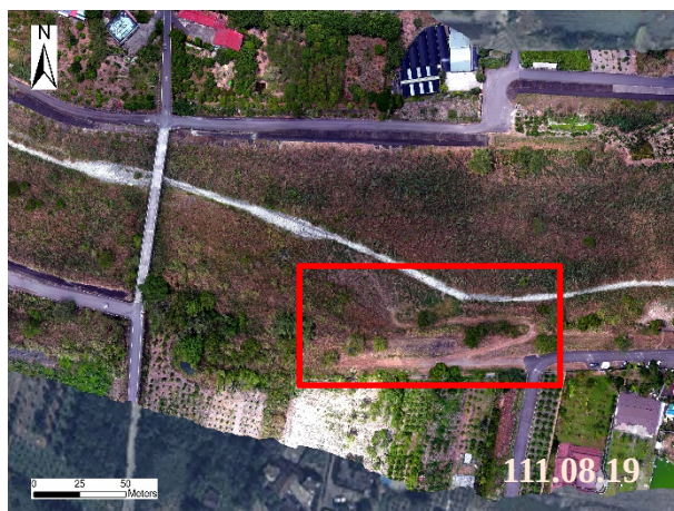
說明：預定工區外，已有農路設施。
