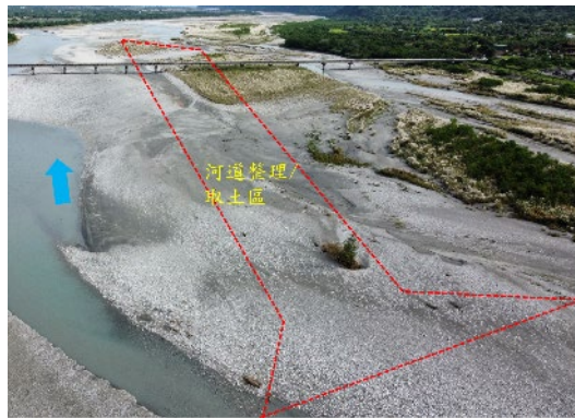
工程範圍右岸河段之空拍照。
