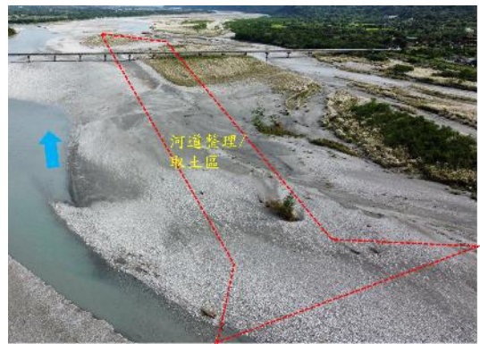
工程範圍右岸河段之空拍照(2022 年 11 月 10 日拍攝)。
