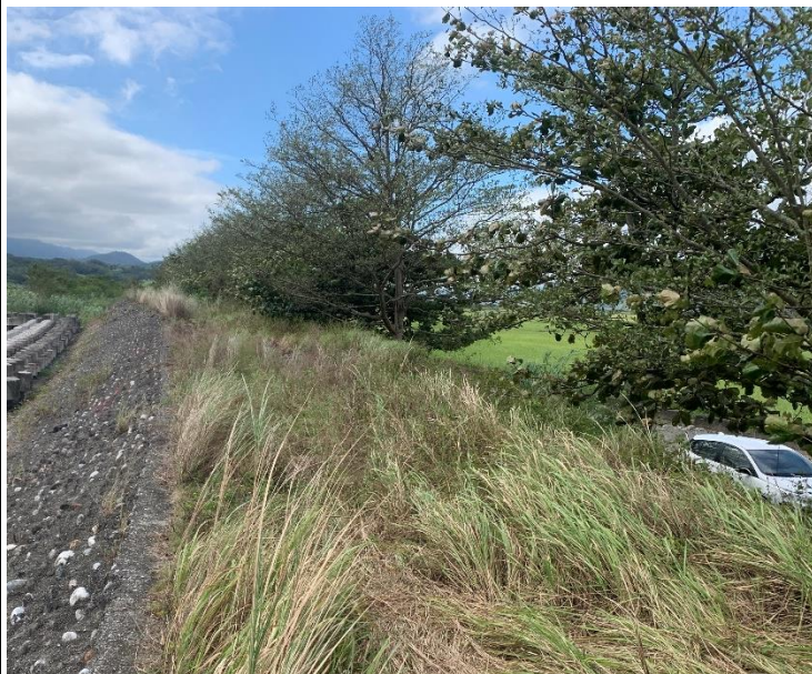
圖三 堤頂的草生植被及堤內的喬木提供良好生態功能
