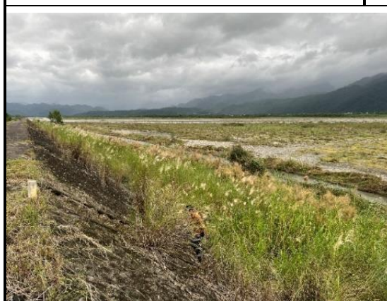
圖3 左岸堤防前坡生長甜根子草及開卡蘆植被
