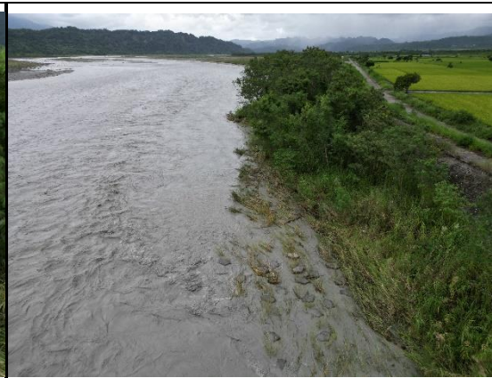
圖5 右岸堤防前坡植被雨水相鄰，發揮濱溪植被功能。
