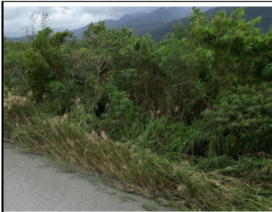
圖4 右岸堤防前坡植被生長茂盛
