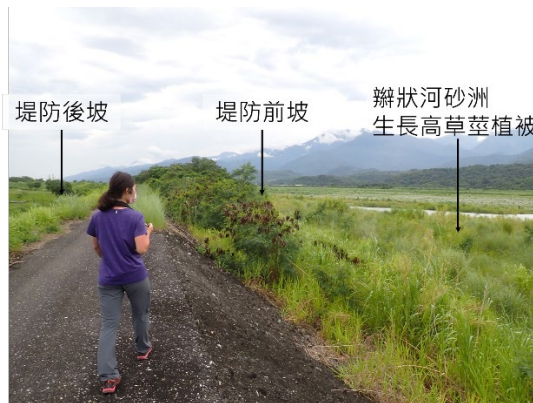
堤防植被覆蓋度高(右岸)，棲地類型為「外來樹種入侵的森林」。
