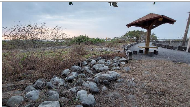
堤前部分區域鋪設塊石 (112.02.17)
