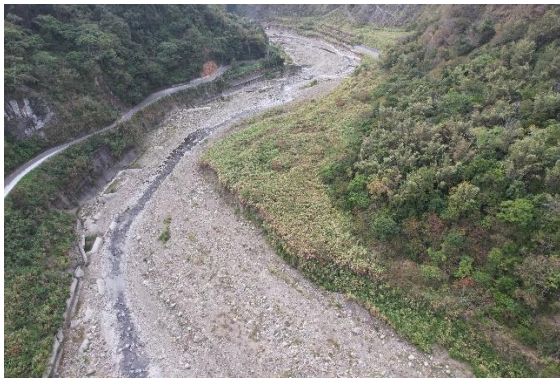
達德安壩上游土砂淤積及道路下邊坡沖蝕
