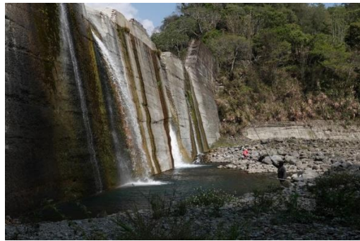
達邦壩落水池 (112.4.11)
