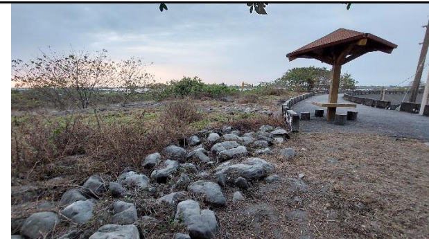
堤前部分區域鋪設塊石 (112. 02. 17)
