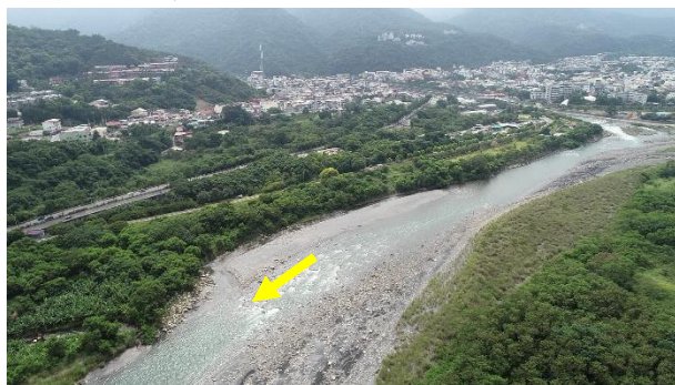
工區環境現況
