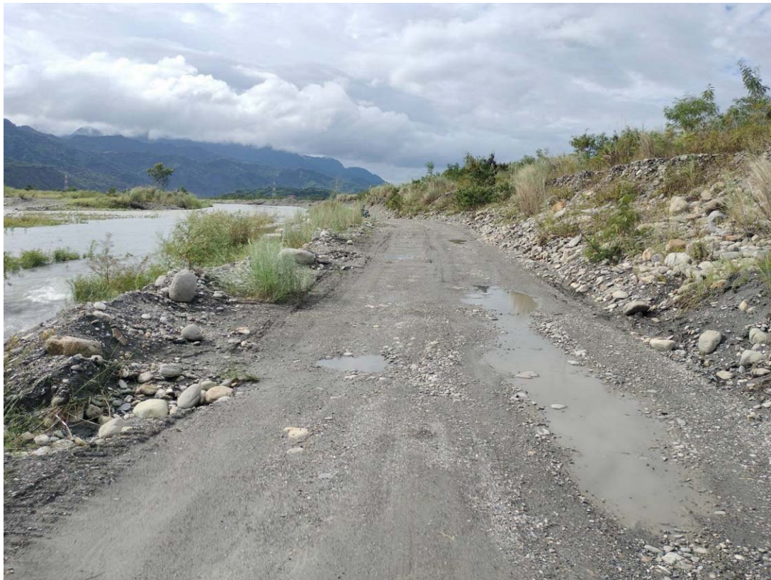
圖 3-5 堤防前坡之灘地因開闢施工便道部分植被已被剷除(施工中 2022/10/10)
