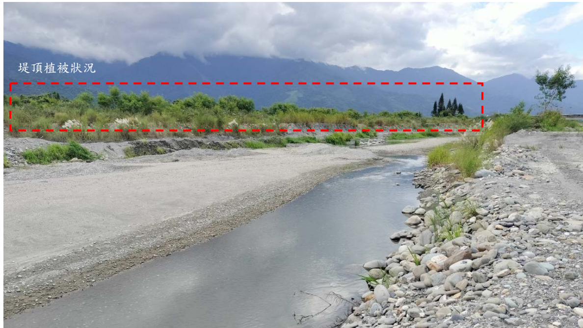
圖 3-4 堤頂植被狀況良好未受影響(施工中 2022/9/2)
