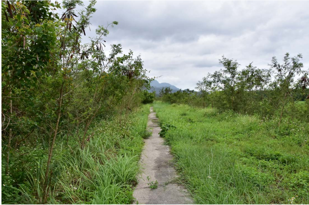
圖 3-2 瑞源堤防堤頂植被狀況(施工前 2022/5/4)
