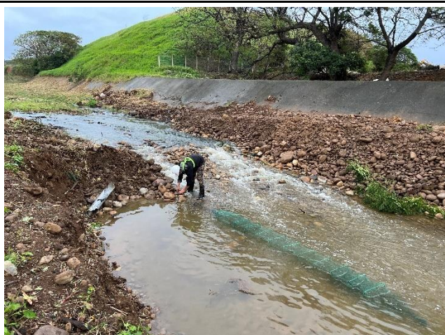
位置或樁號：24.939188, 121.029135 說明：工區上游深潭與瀨區保留
