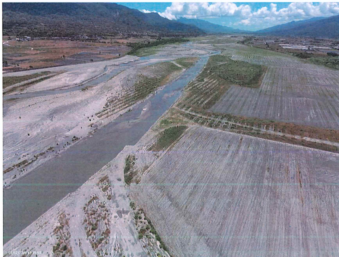
圖、完工後主流路及河道整理區(面朝上游) 拍攝日期：112.07.12
