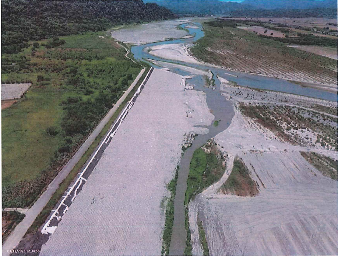
圖、完工後加納納工區細部狀況(面朝下游) 拍攝日期：112.07.12
