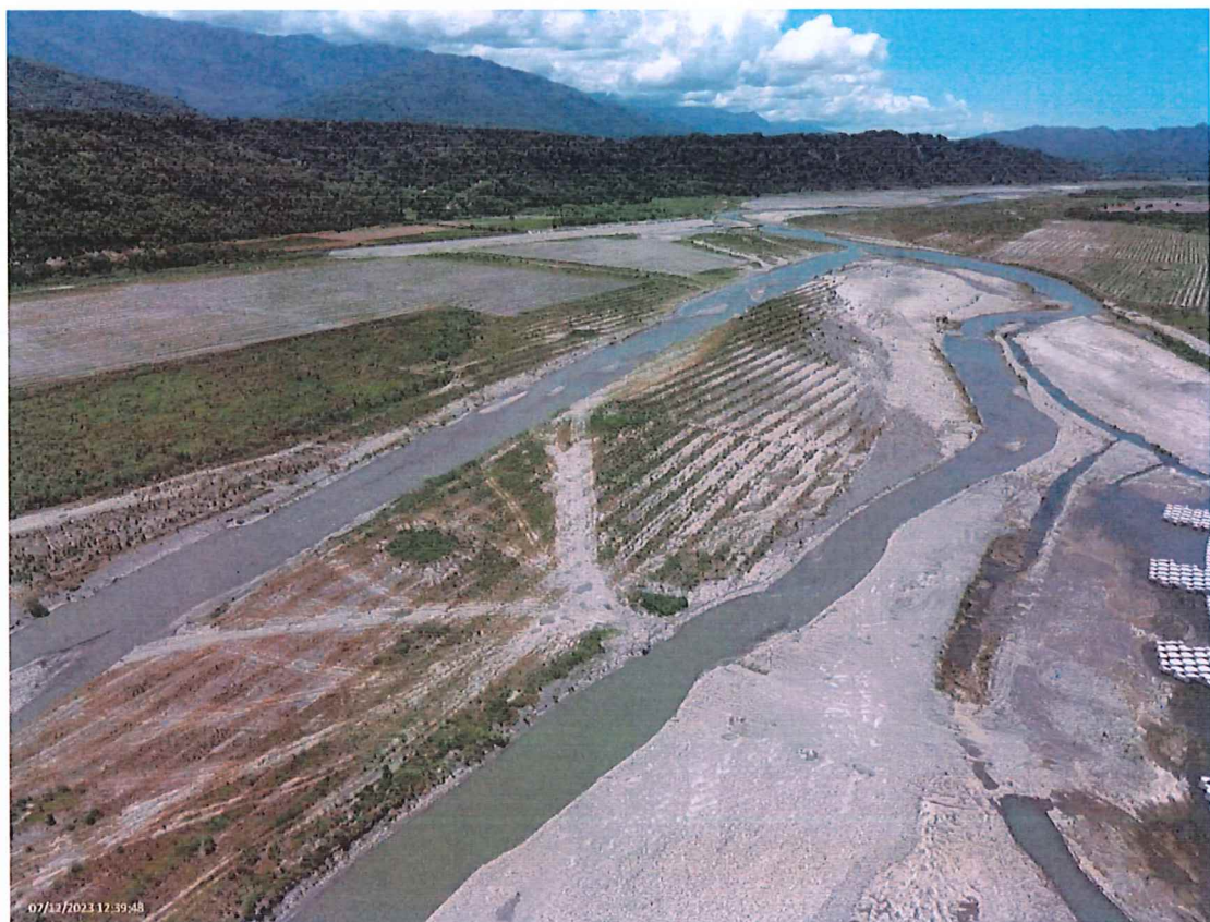
圖、完工後主流路及河道整理區(面朝下游) 拍攝日期：112.07.12
