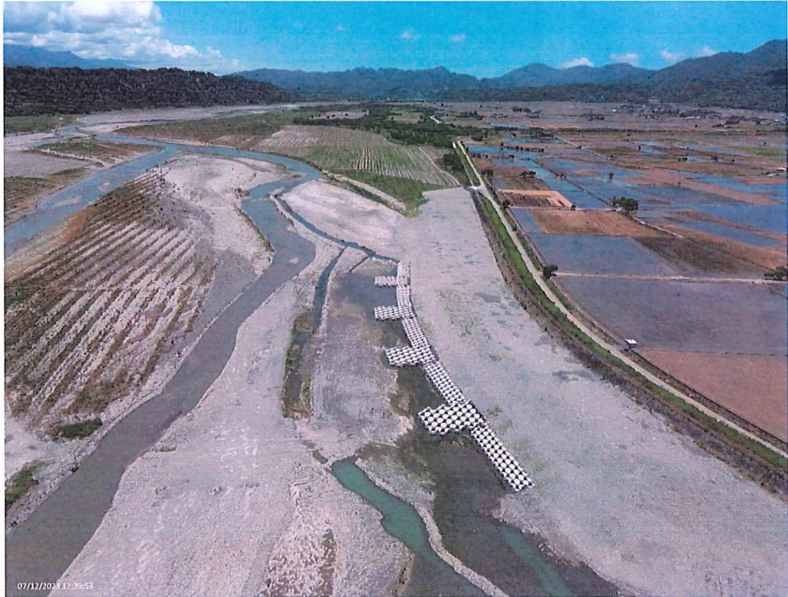
圖、完工後松浦工區細部狀況(面朝下游) 拍攝日期：112.07.12
