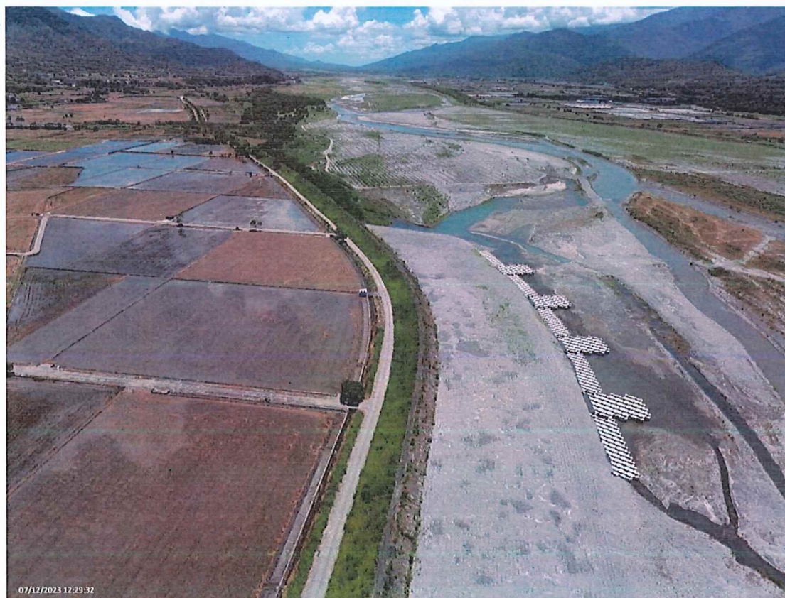
圖、完工後松浦工區細部狀況(面朝上游) 拍攝日期：112.07.12
