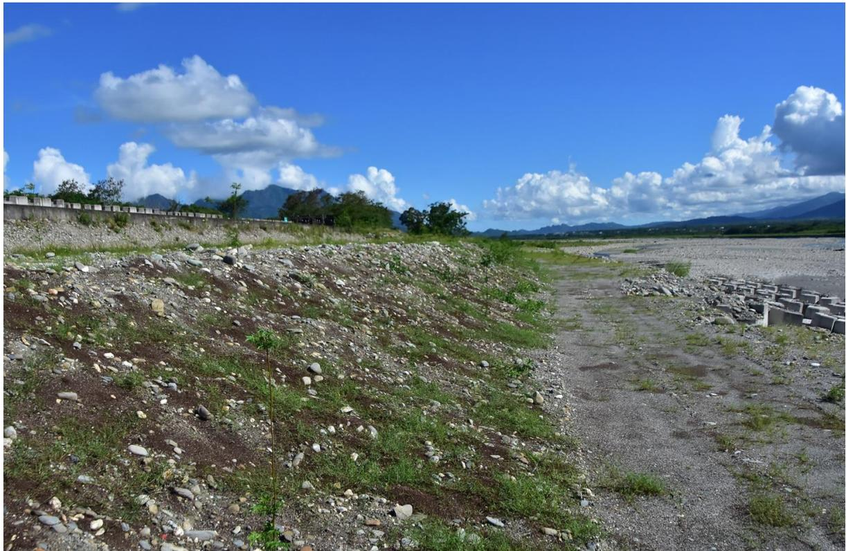
圖 3-2 電光三號堤防之堤前為人工栽植之植生區
