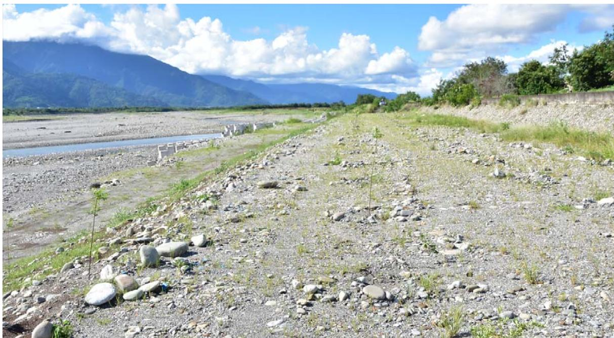
圖 6-1 電光三號堤防堤前人工栽植之植生區
