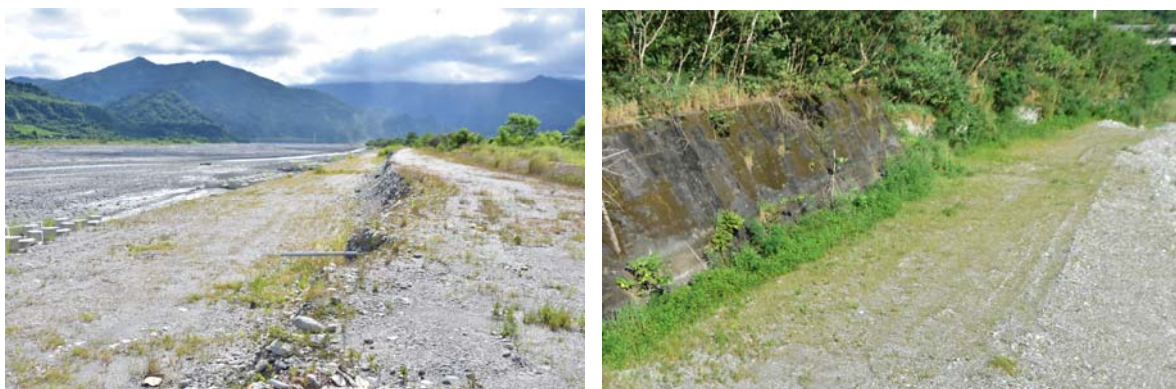
圖 6-1 保護工覆土區之新植草類生長情況(左：和平工區；右：鹿寮工區)
