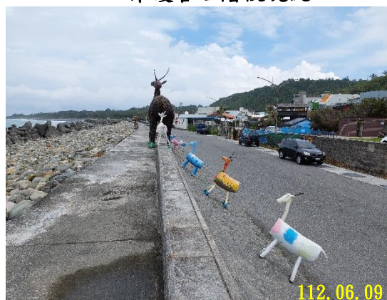
位置：堤頂羊群裝置藝術 維護管理階段現況
