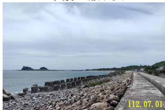
位置：工區北側保護工坡面(工區外) 維護管理階段現況
