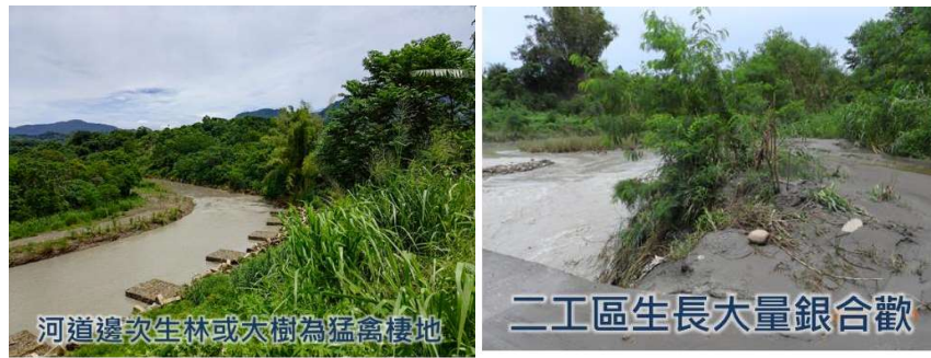
圖 4.2-59 後堀溪三埔段護岸改善工程環境現況
