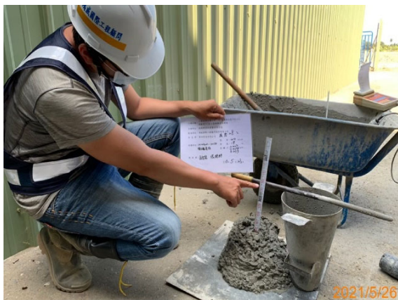
混凝土試體取樣
