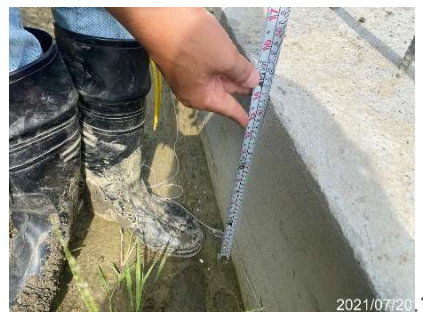
澆置完成尺寸量測
