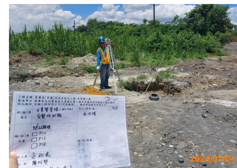
全套管基樁完整性試驗
