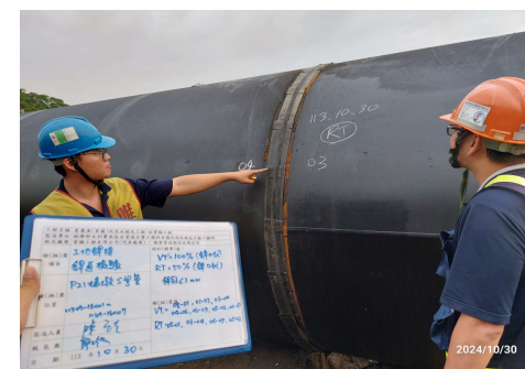
鋼管鉚接RT、VT
