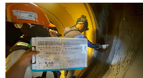
鋼管C線銲接UT
