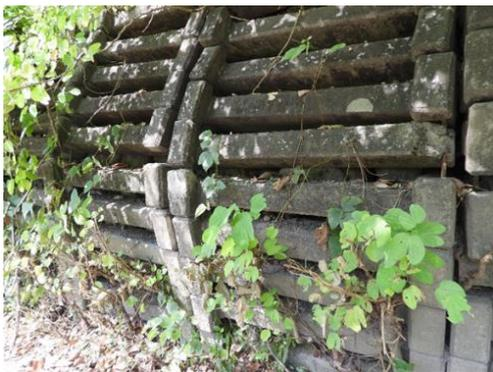
原擋土結構有因無法抵擋後方壓力而有損毀現象
