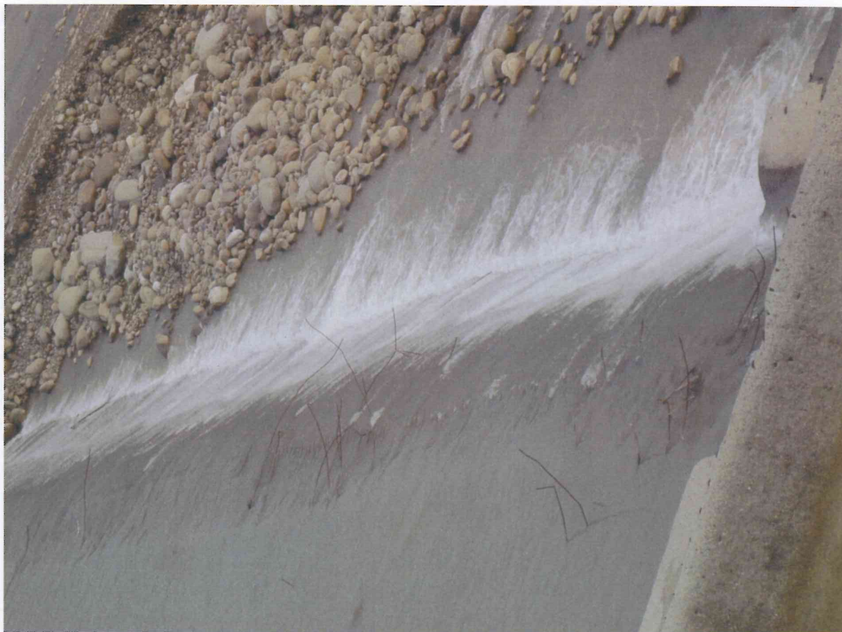
附圖七、落水池尾檻鋼筋裸露情形
