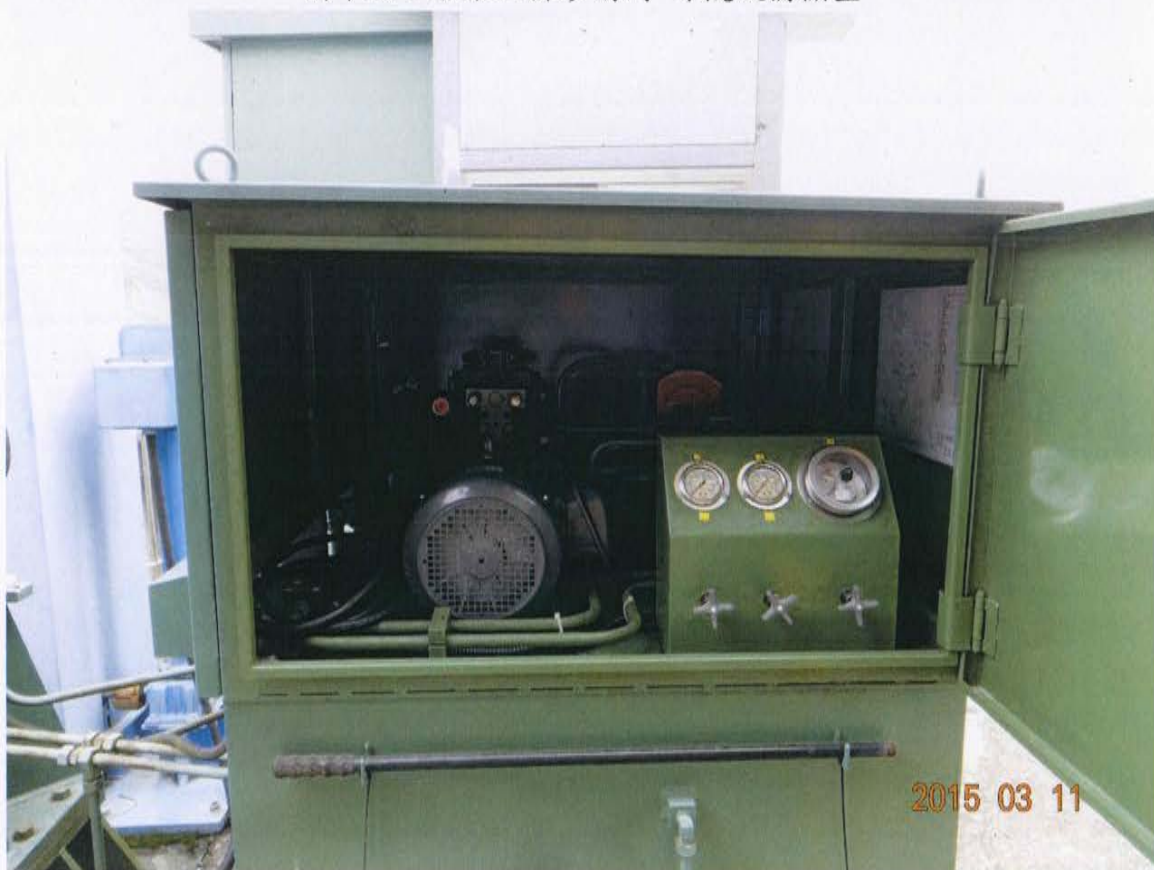
圖十六：取水口排砂閘門-油壓運轉檢查
