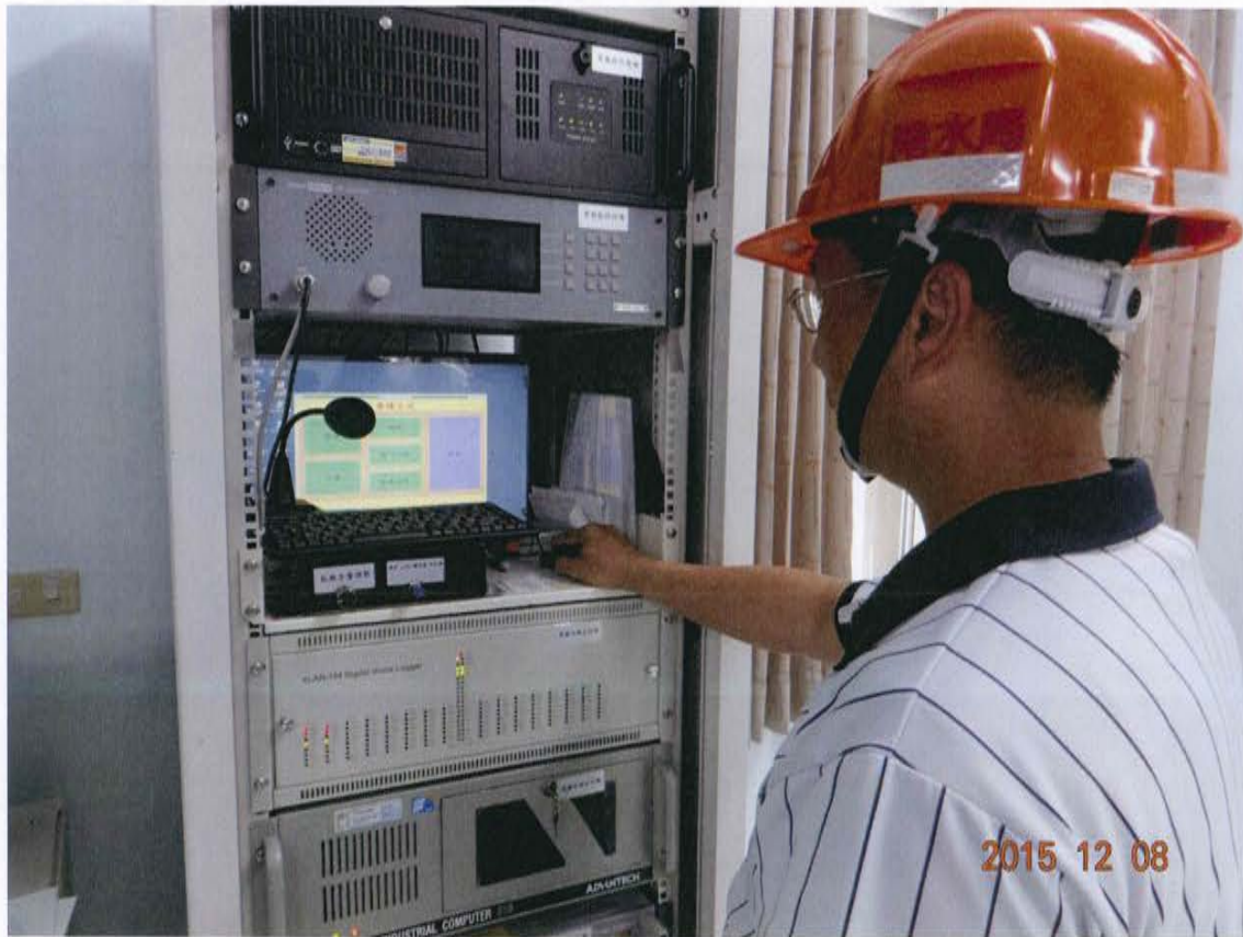
圖十九：放水警報廣播系統-警報廣播測試
