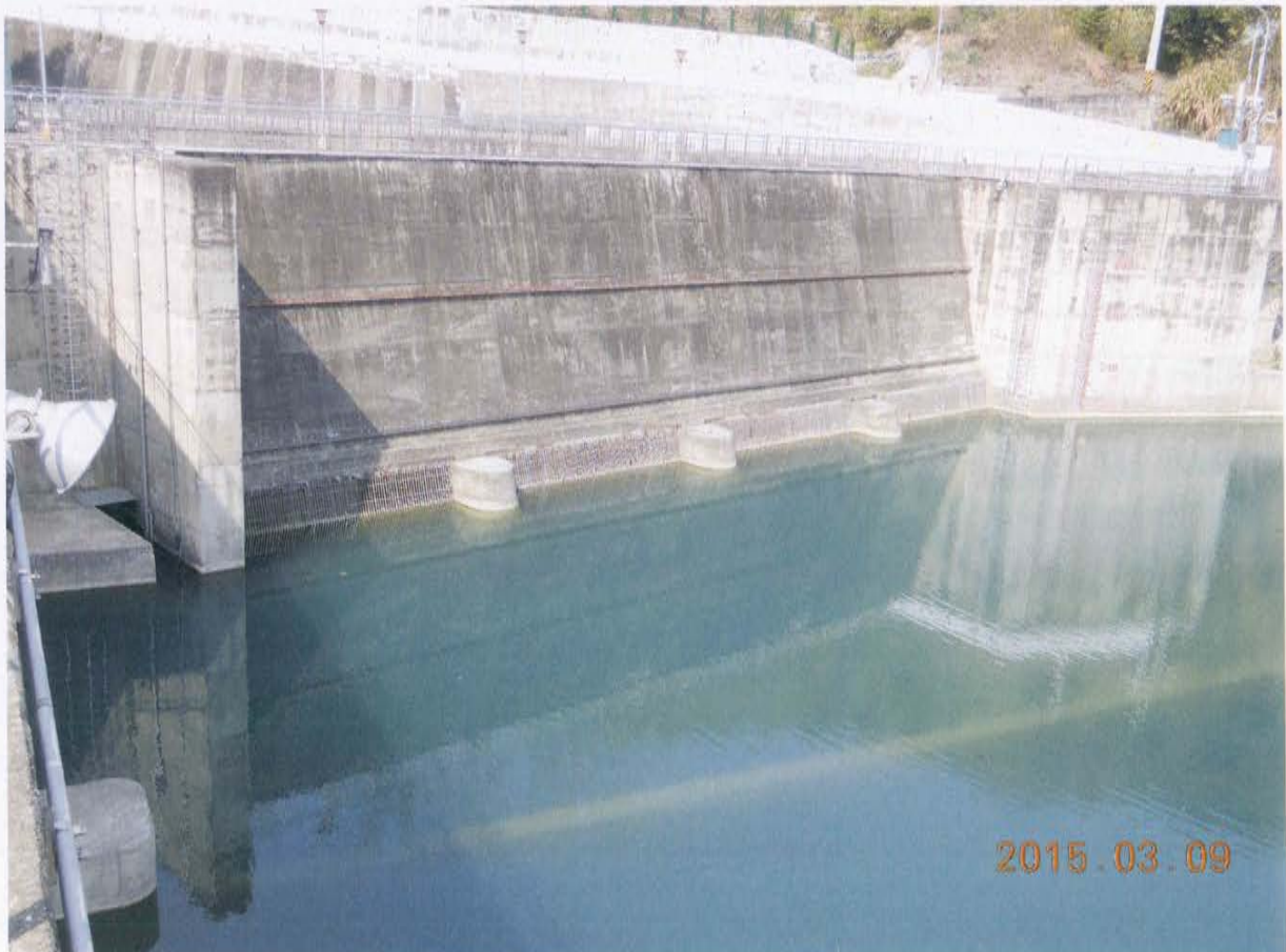
圖四:取水口混凝土結構完整
