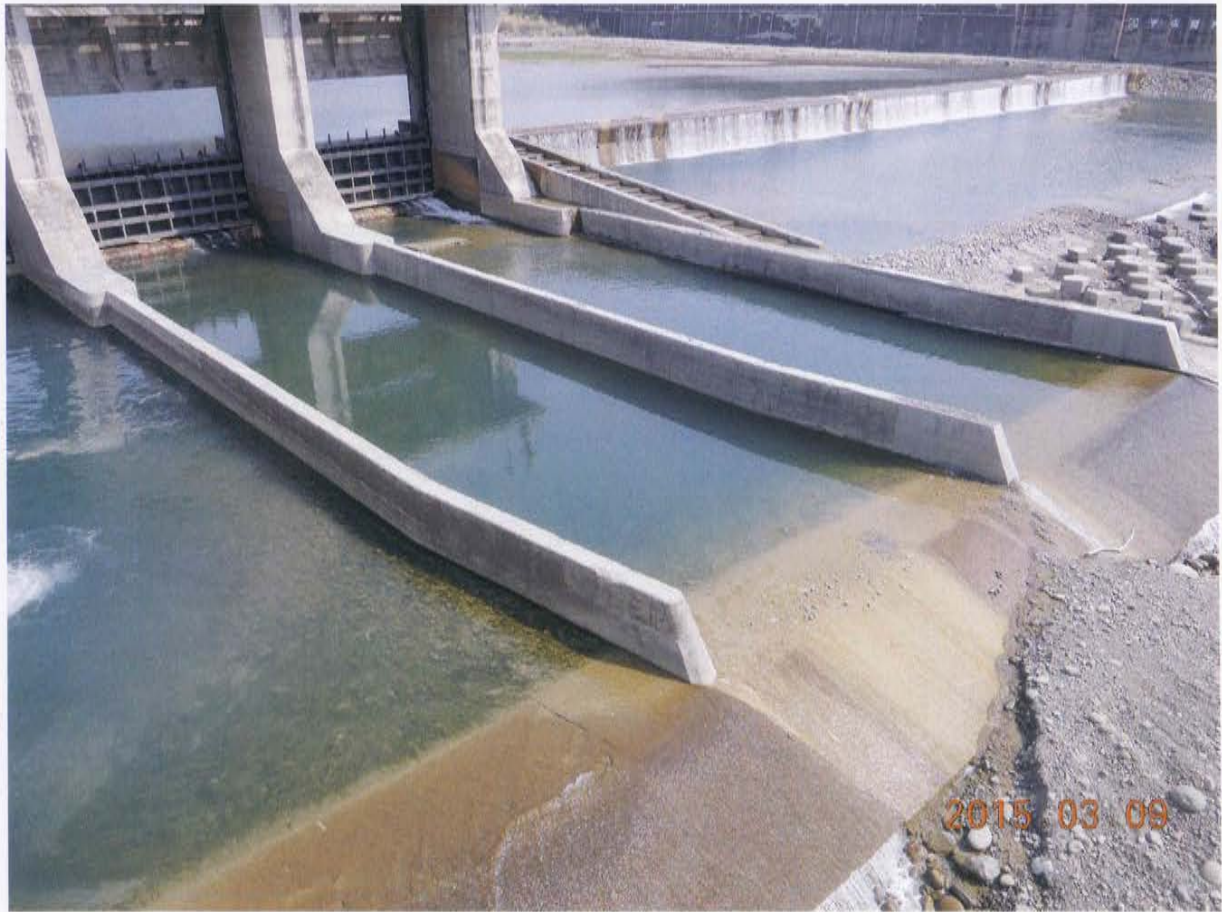
圖三:排砂道導流牆、操作橋橋墩、尾檻及門框均完整
