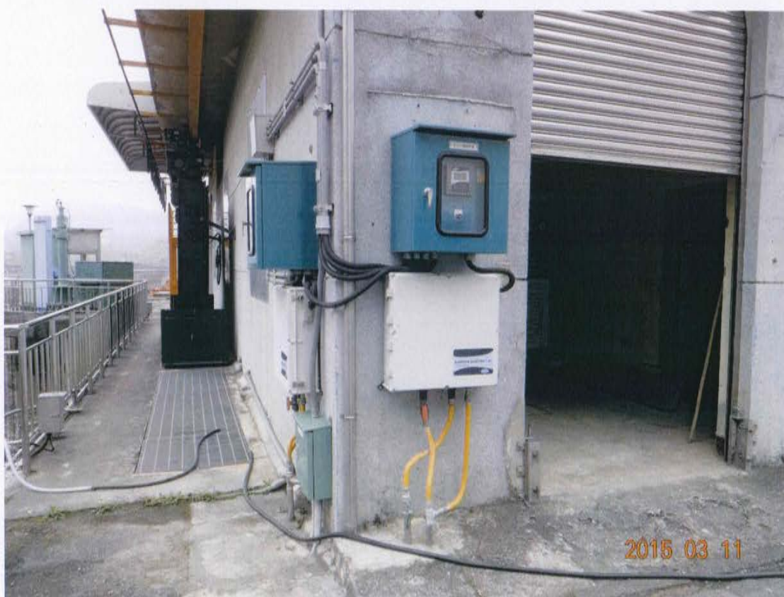
圖二十四：監測儀器檢查-濁度計
