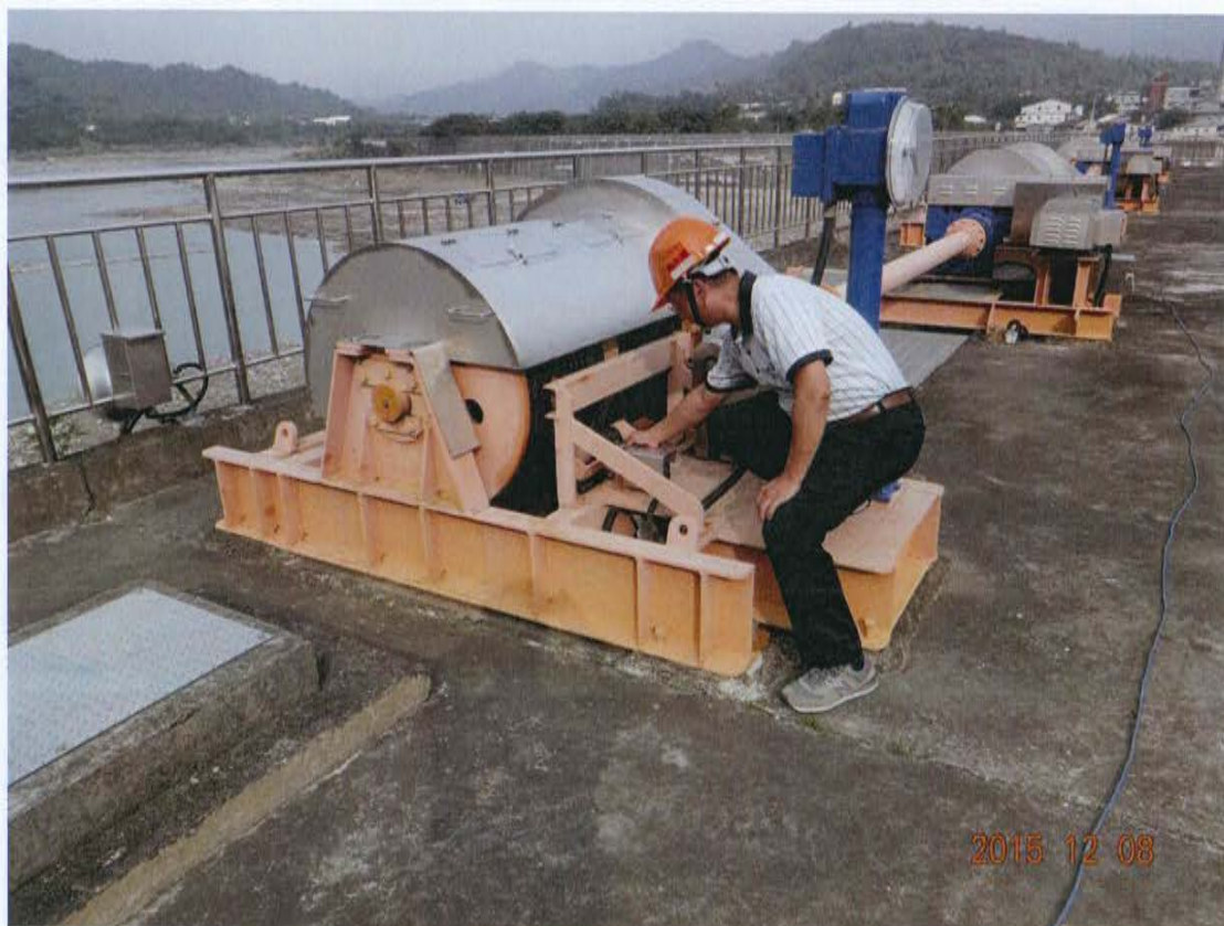
圖十一：排砂道擋水閘門-極限開關功能檢查
