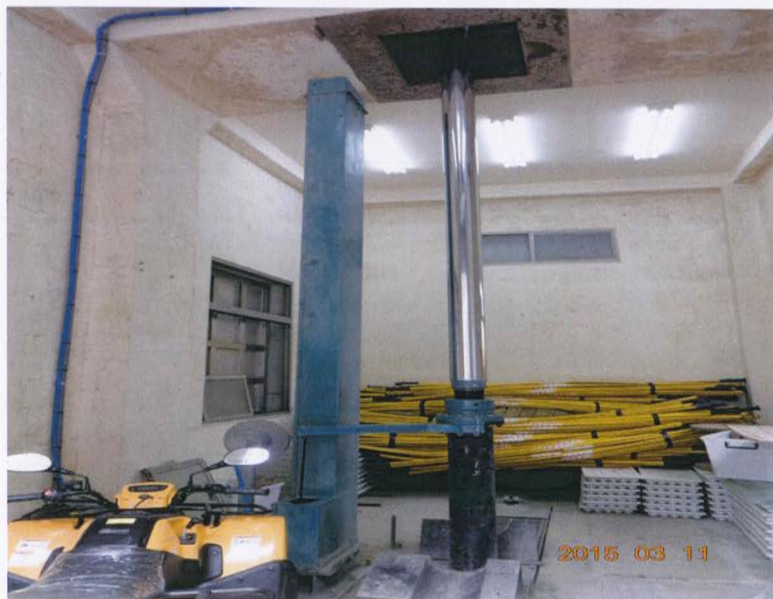
圖十八：取水口沉沙池排砂閘門-油壓設備檢查
