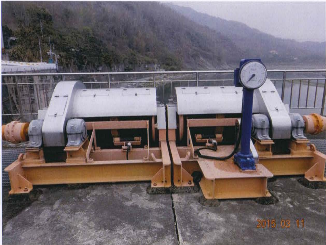
圖十一：排砂道擋水閘門-開度指示器檢查
