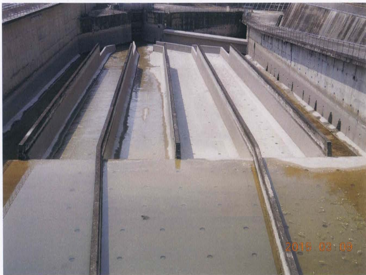
圖五:沉砂池結構完整
