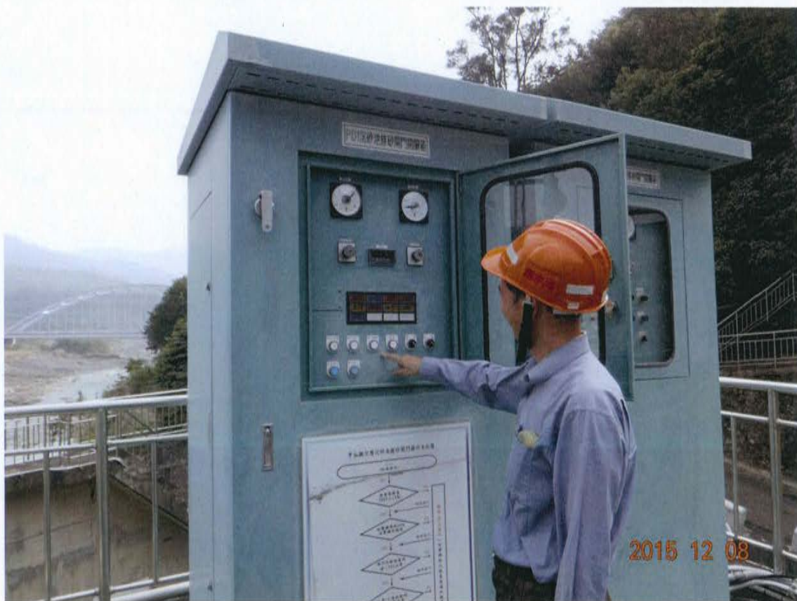
圖十七：取水口沉沙池排砂閘門-電源及油壓設備運轉檢查
