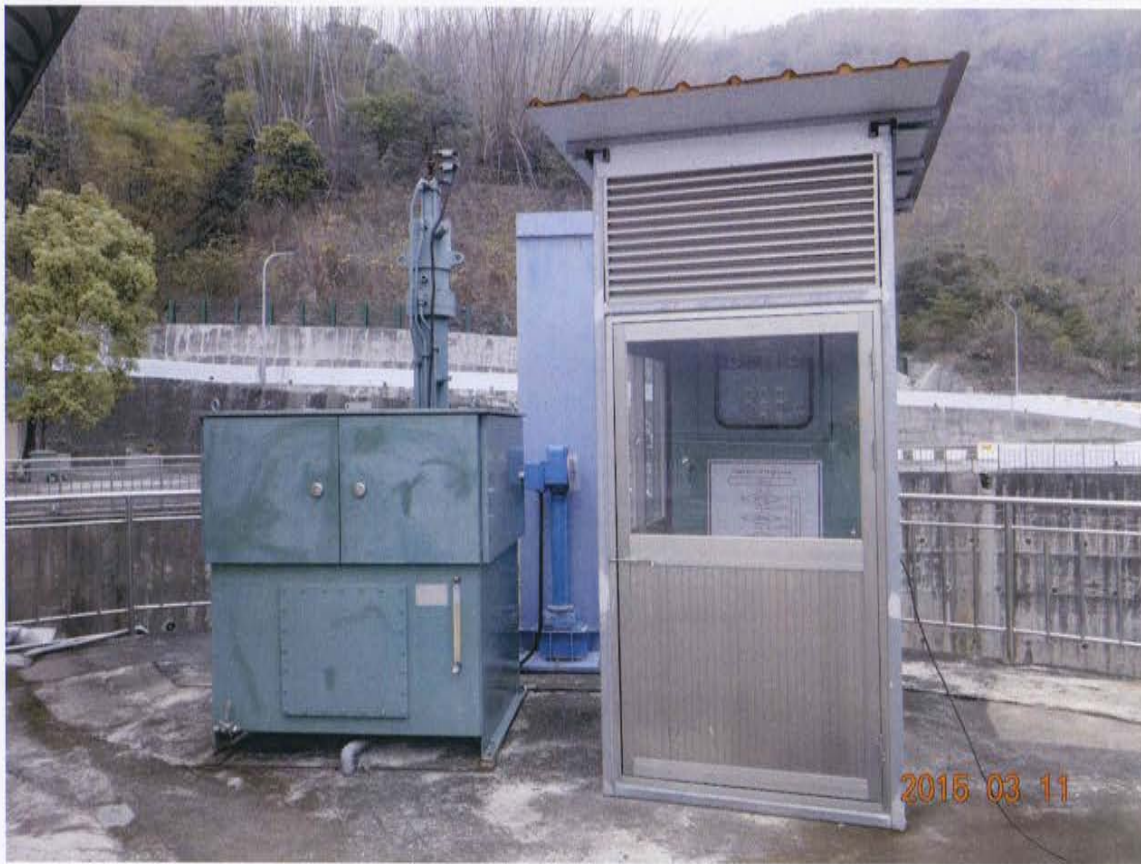
圖十五：取水口排砂閘門-外觀設備檢查
