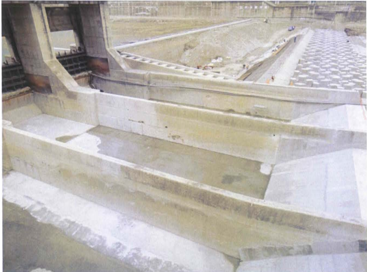
附圖六 排砂道底版修復完成
