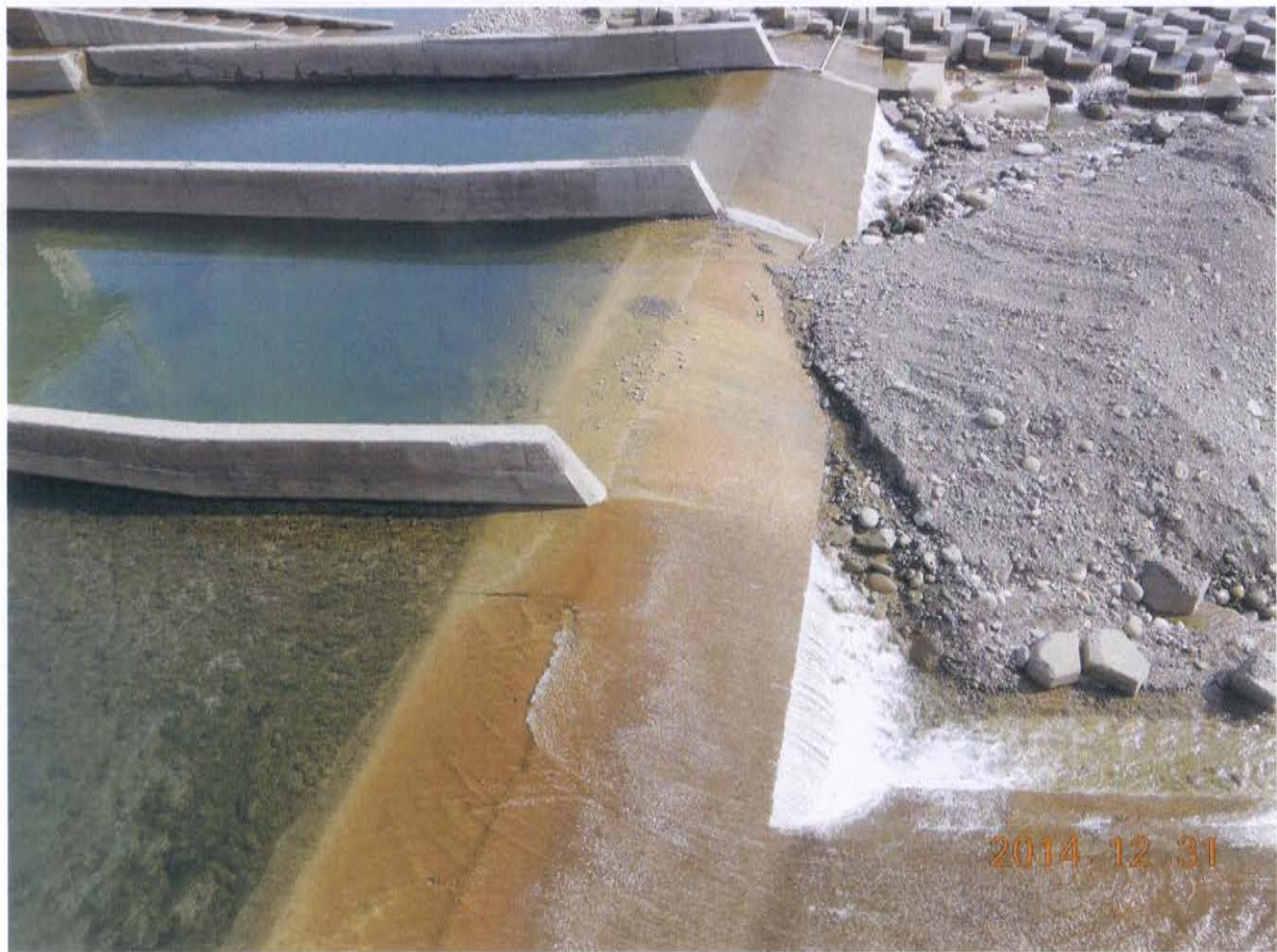
圖十:排砂道尾檻完整
