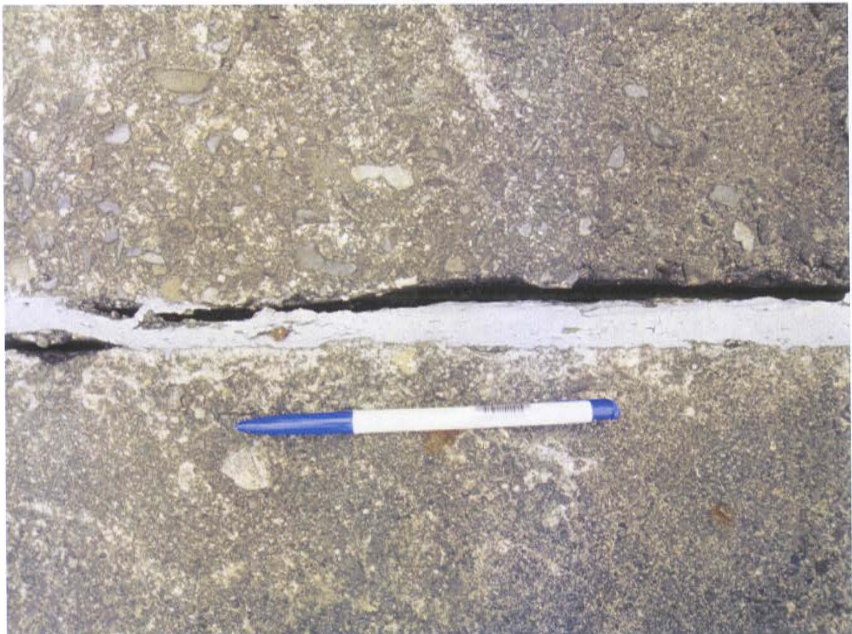
附圖八 防洪牆擴張情形
