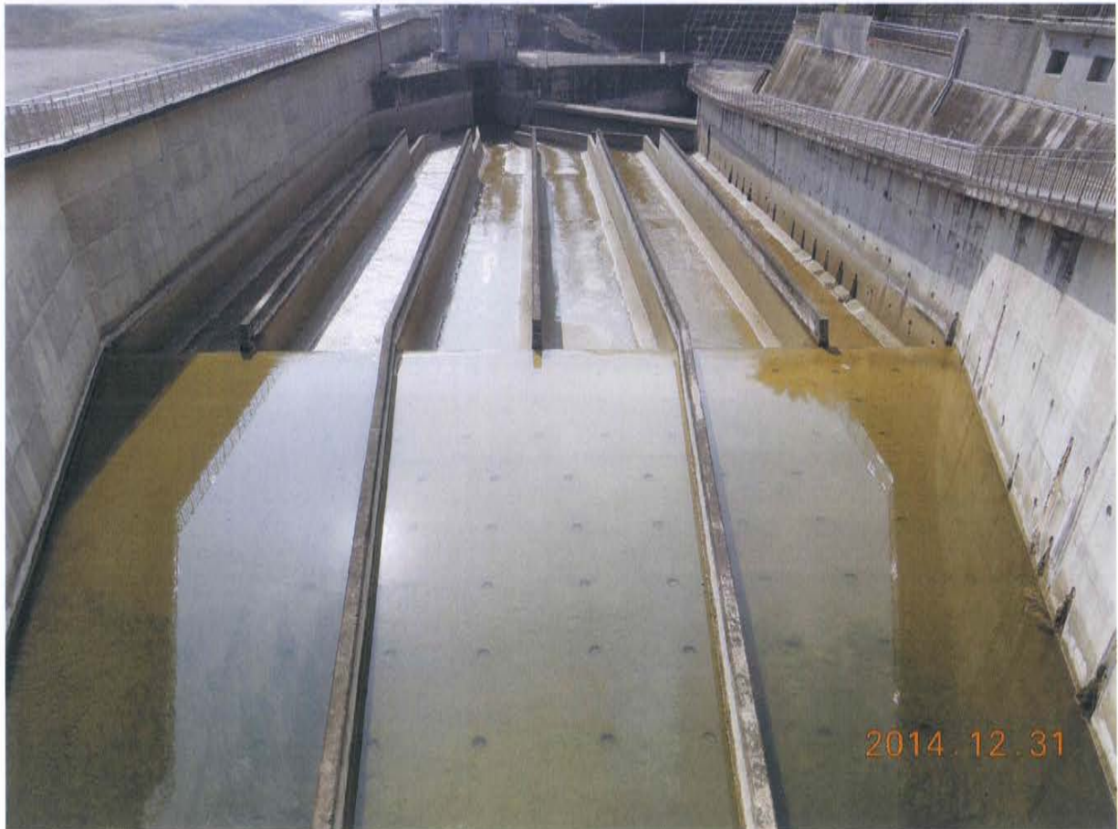
圖十四:沉砂池混凝土結構完整
