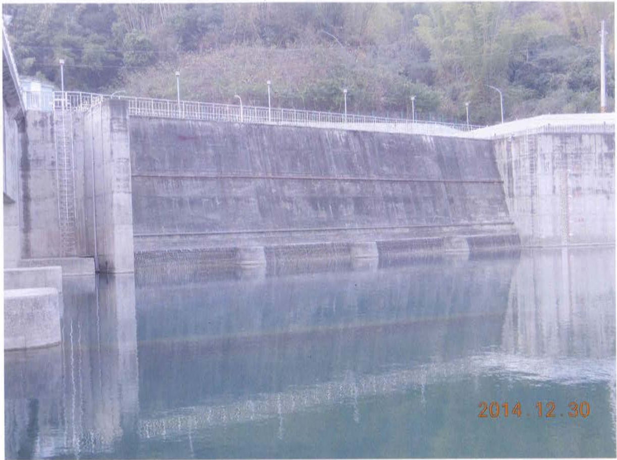
圖十一:取水口進水口結構完整
