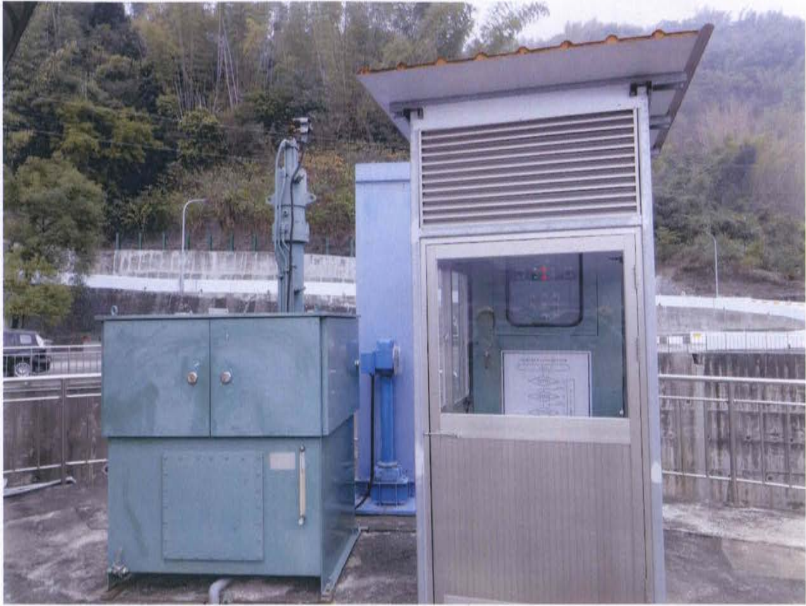
圖二十九：取水口排砂閘門-外觀設備檢查
