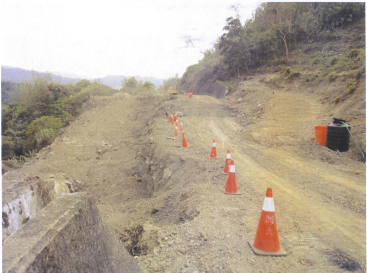
附圖十 引水隧道出口聯外道路崩塌處辦理修復中
