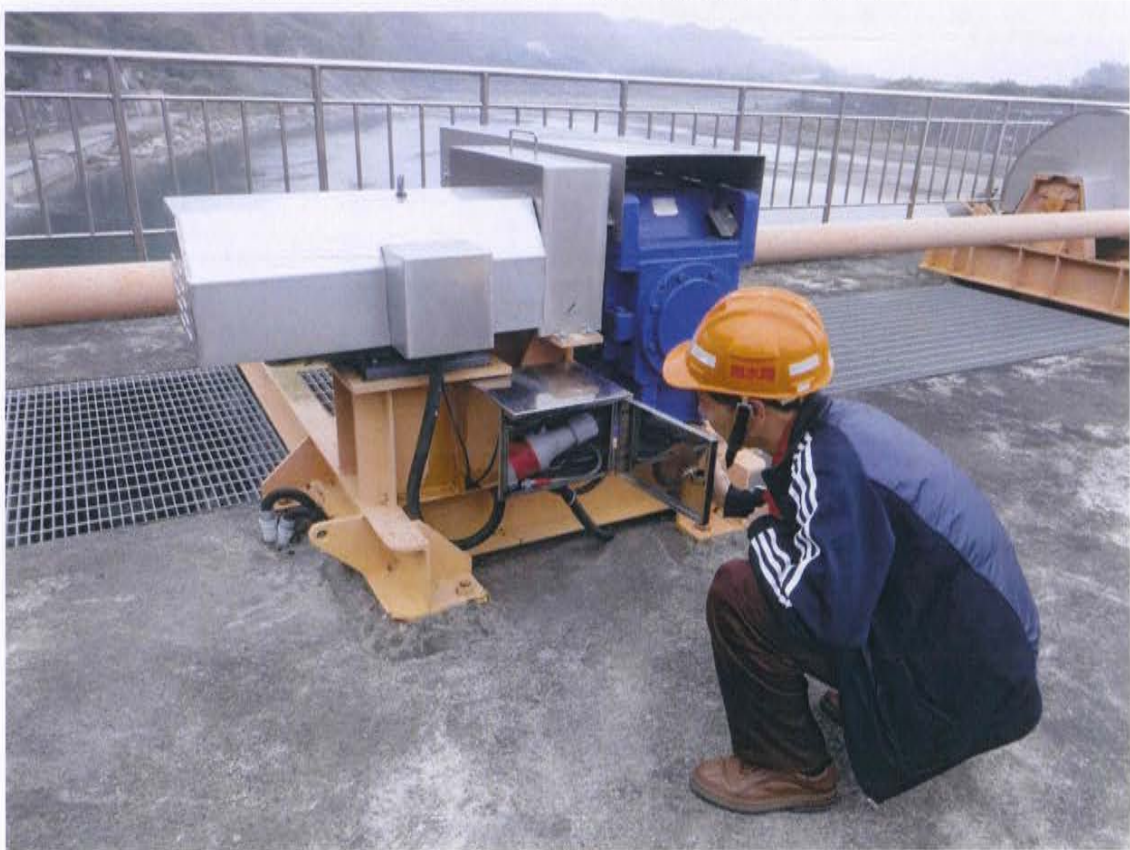
圖二十六：排砂道擋水閘門-緊急線路設施檢查
