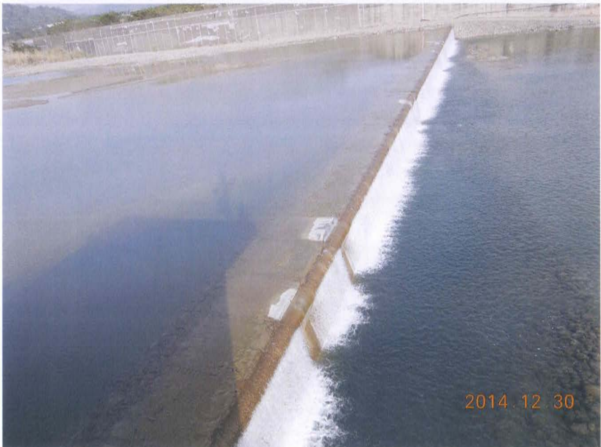
圖二：堰頂現況良好，惟增加覆蓋之橡皮有部分因內部淤砂而隆起
