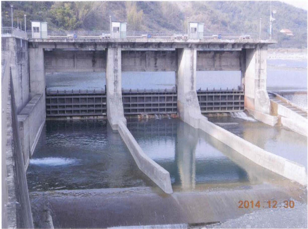
圖九:操作橋橋墩完整
