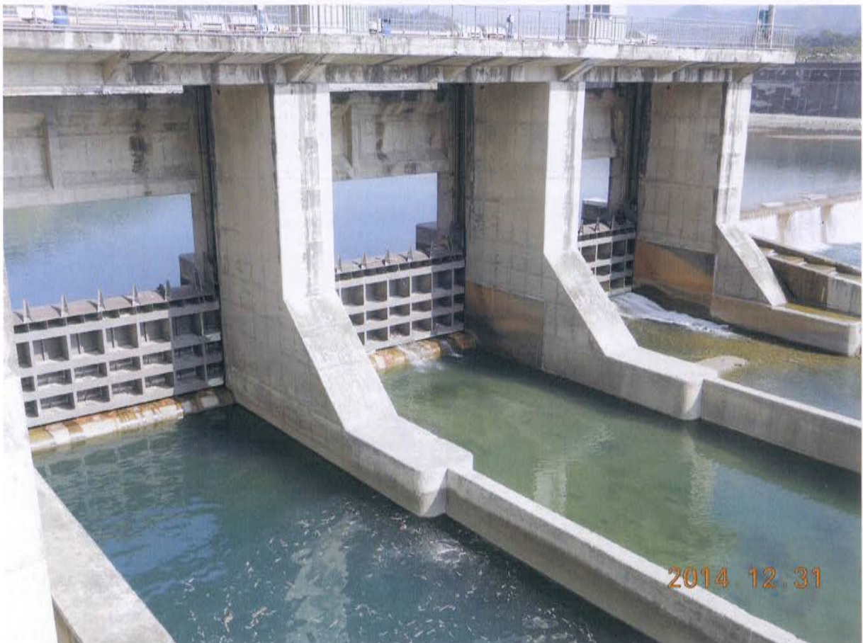
圖八：堰面與操作橋橋墩交接處完整
