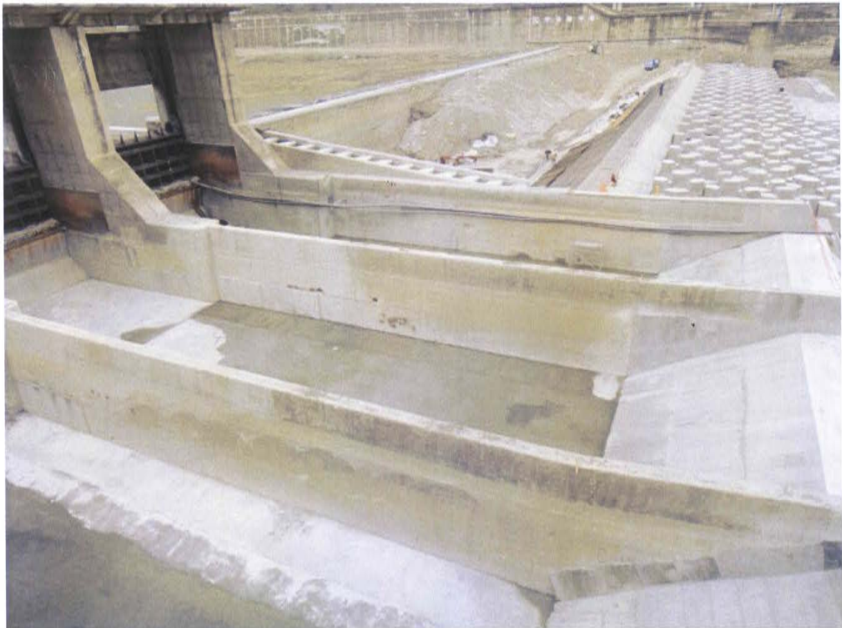
附圖四 排砂道導流牆修復完成
