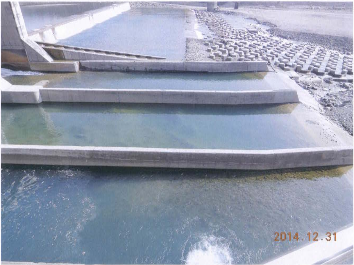
圖七：排砂道導流牆完整
