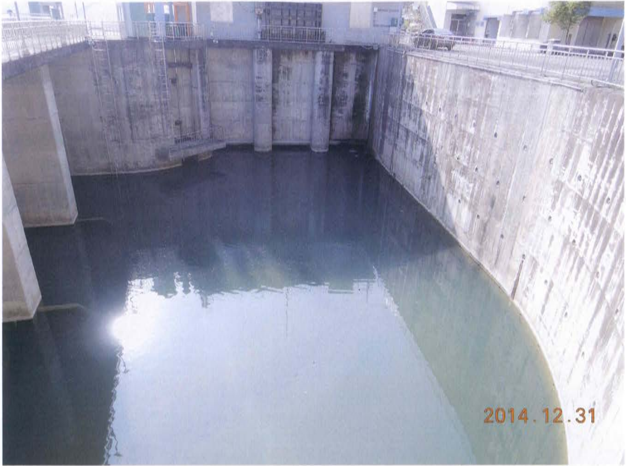
圖十三:取水口進水口結構完整
