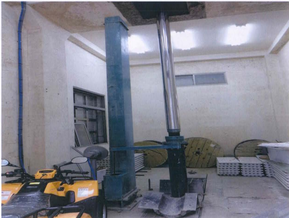
圖三十二：取水口沉沙池排砂閘門-油壓設備檢查
