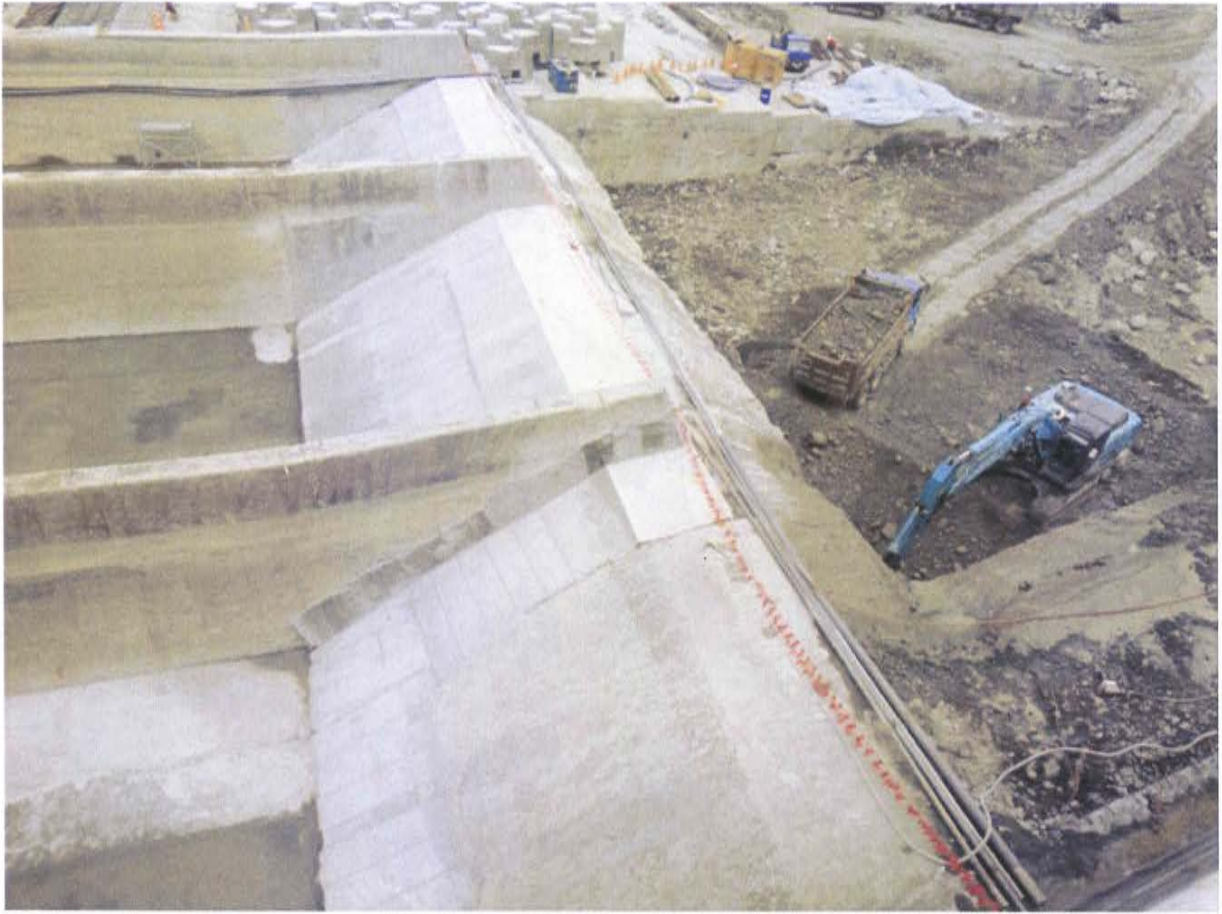
附圖五 排砂道尾檻辦理修復中
