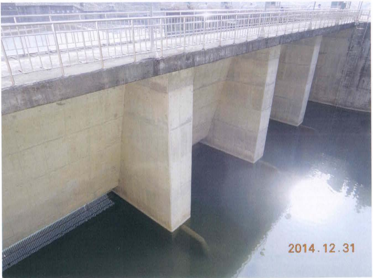
圖十二:取水口進水口結構完整
