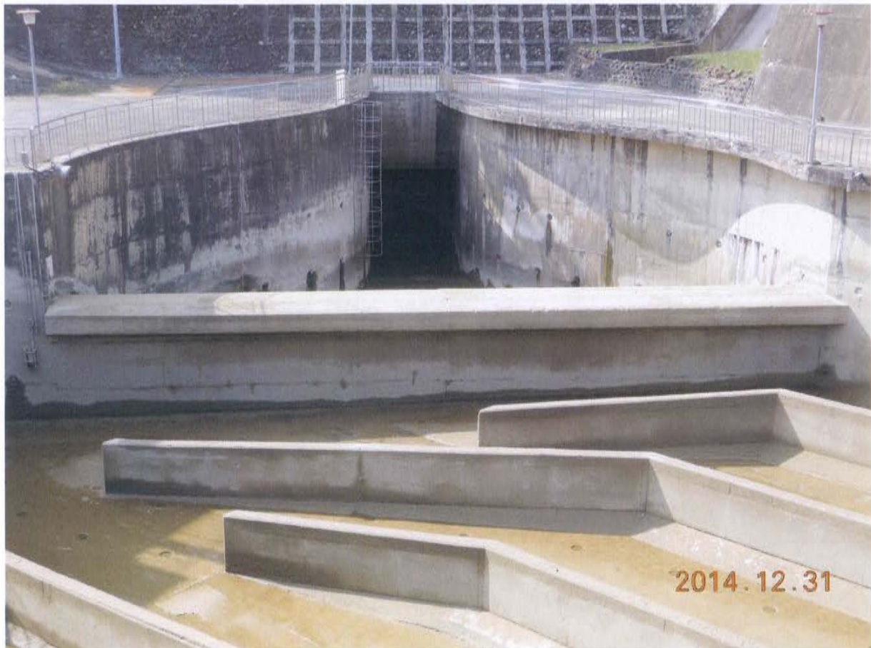
圖十六:入口堰結構完整
