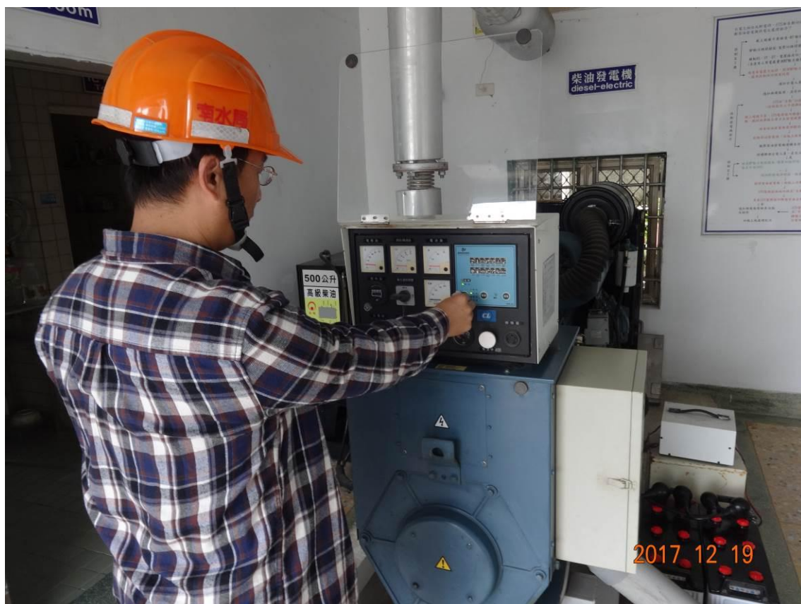
圖 5.4.1：控制室緊急發電機(125KW)檢查
