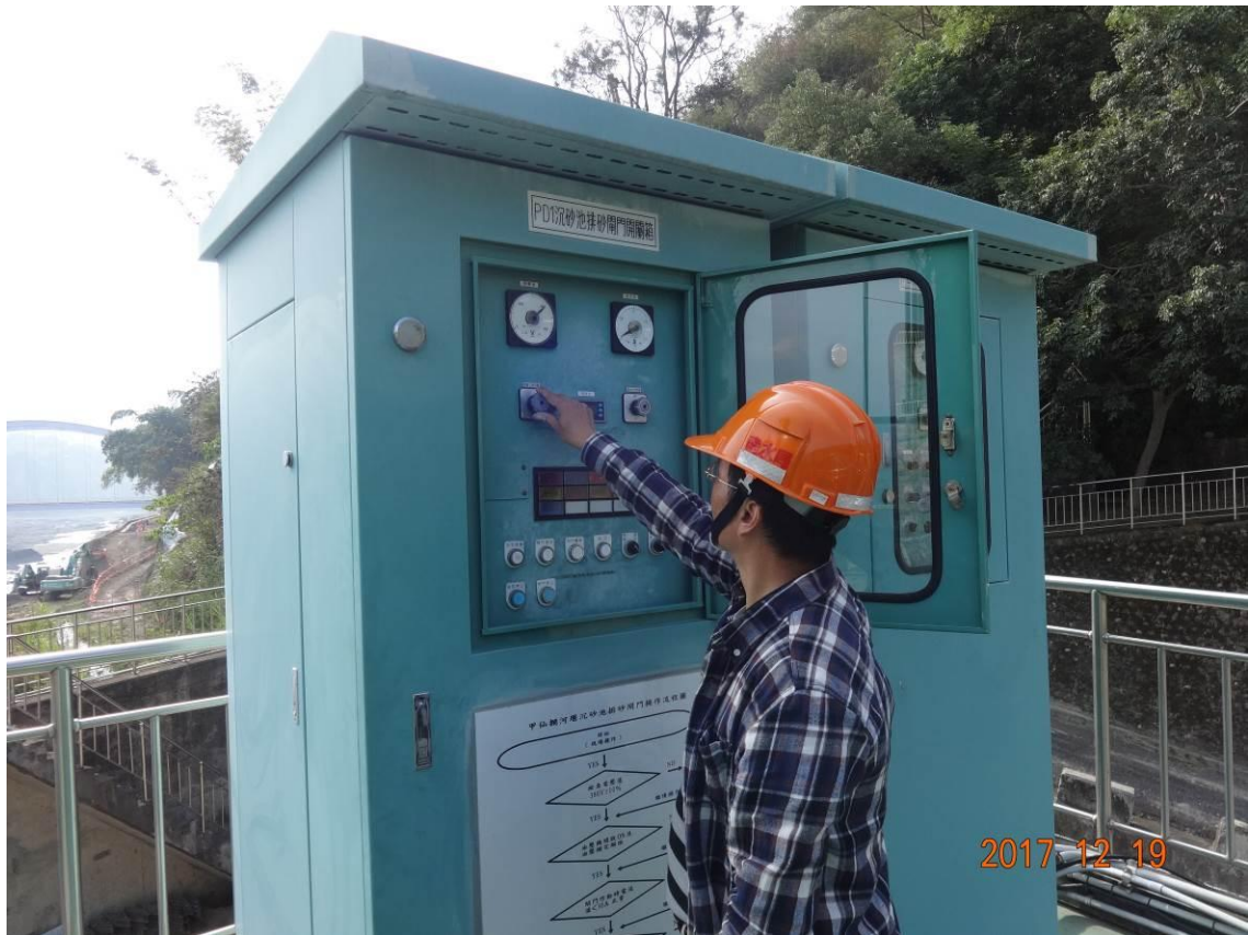
圖 4.4.1：沉沙池排砂閘門-控制箱電源及運轉檢查
