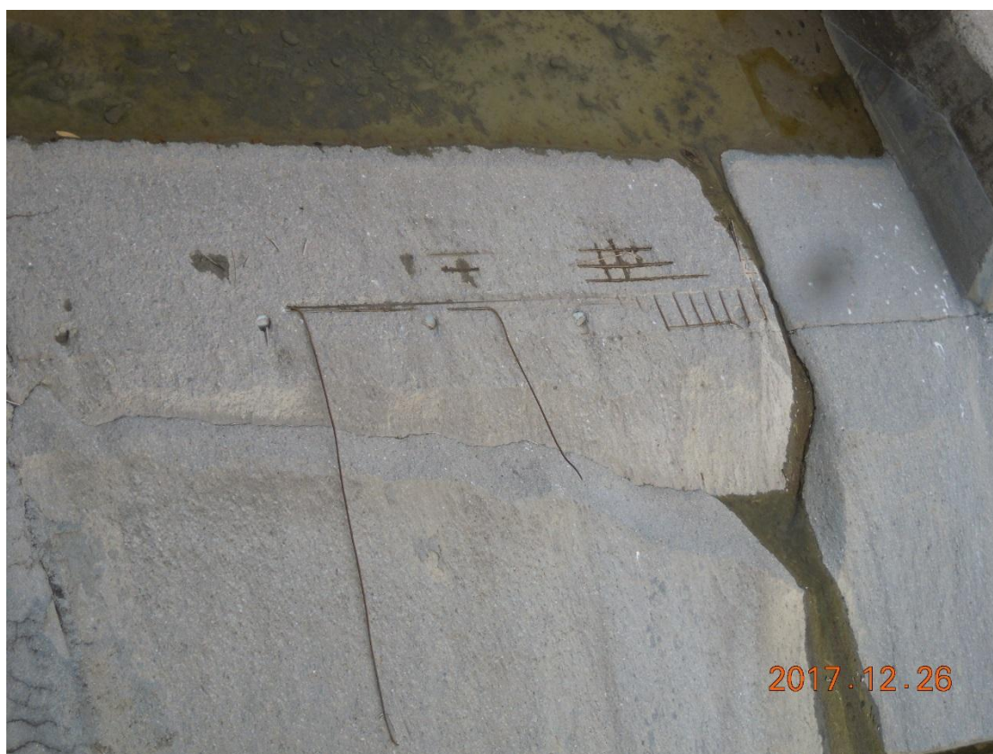
圖 1.2.3：#1 排砂道尾檻磨耗
