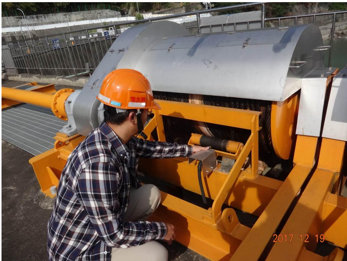
圖 4.1.2：排砂道擋水閘門-外部檢查
