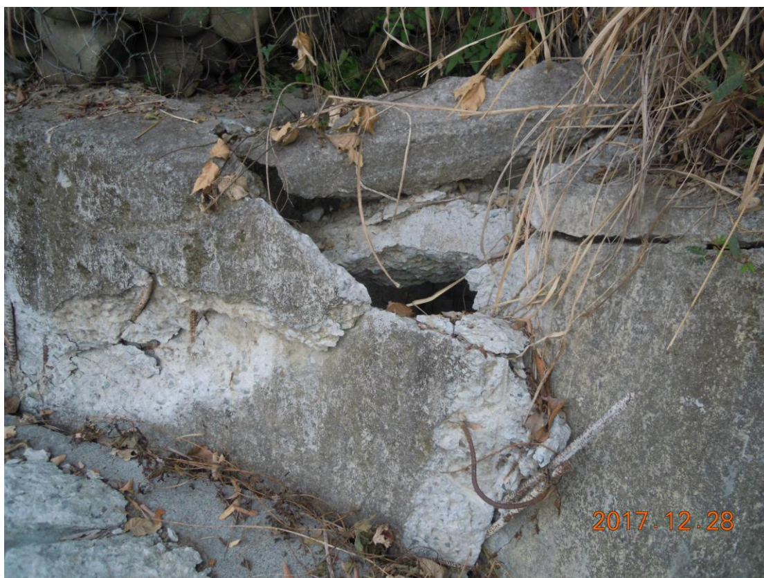
圖 7.1：道路 A 邊坡管理中心下方擋土牆有多處裂縫
