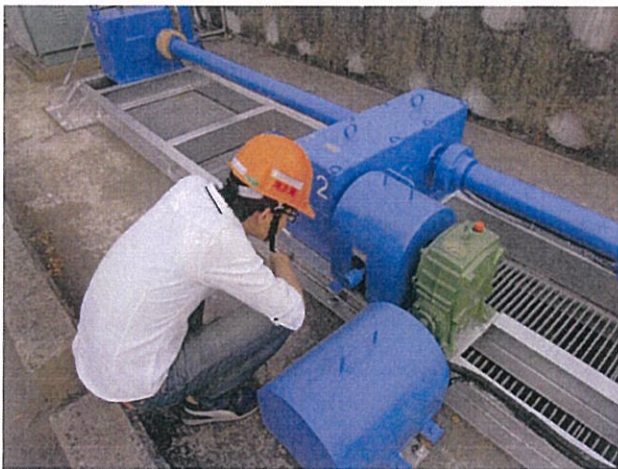
進水口一至十四號閘門設備檢查
