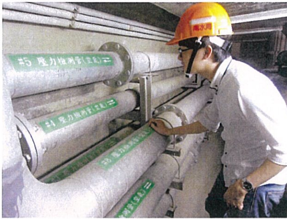
橡皮壩一至八號壓力管路檢查
