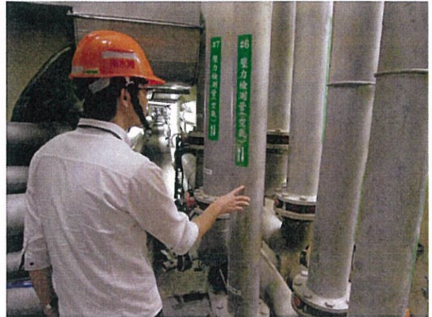
橡皮壩一至八號壓力管路檢查
