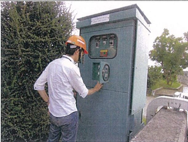
放水路一至三號閘門控制盤檢查
