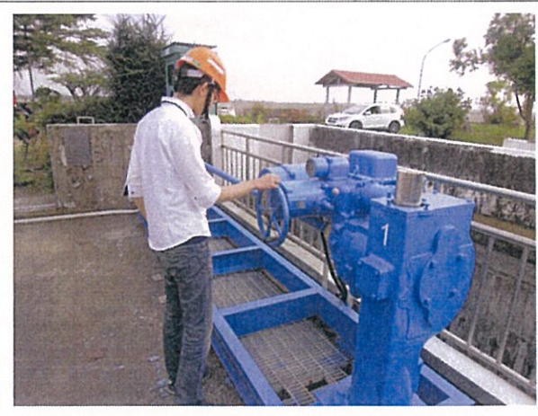
放水路一至三號閘門設備檢查
