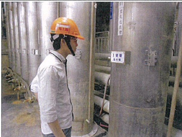
橡皮壩一至八號空氣溢出槽檢查
