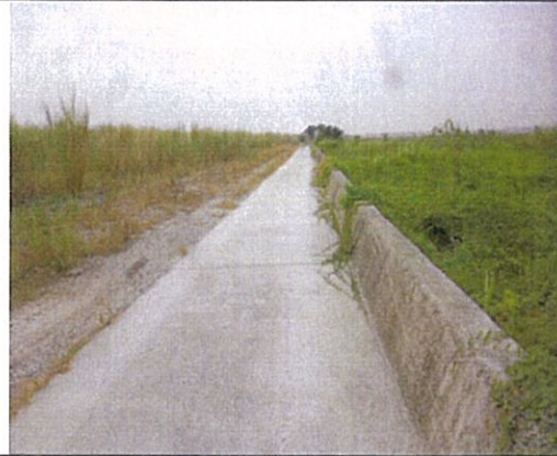
9. 右岸低水護岸尚完整
