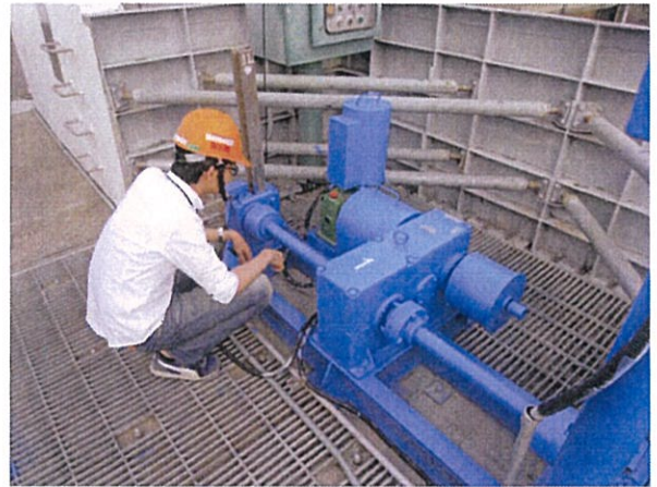
側槽取水路閘門設備檢查
