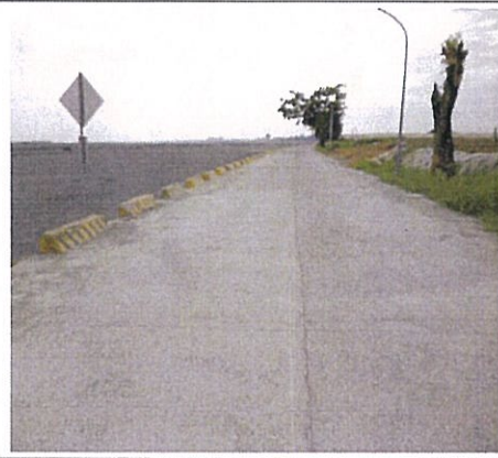
10. 左岸低水護岸尚完整
