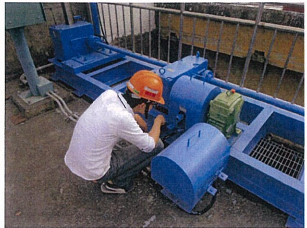
取水路一至三號閘門設備檢查
