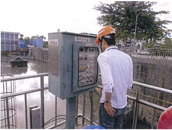
側槽取水路閘門控制盤檢查
