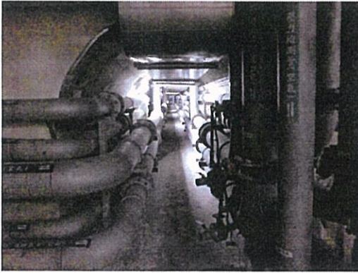
11. 廊道結構尚完整
