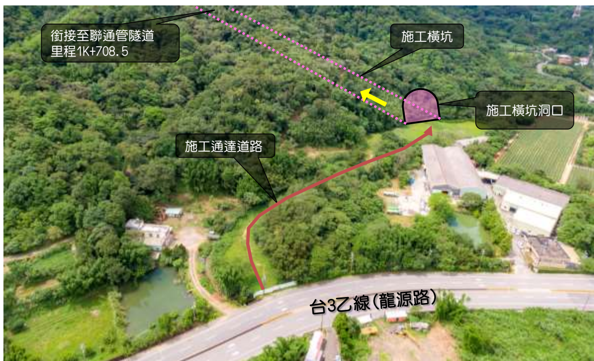
圖 7-13 施工橫坑洞口現況照片
