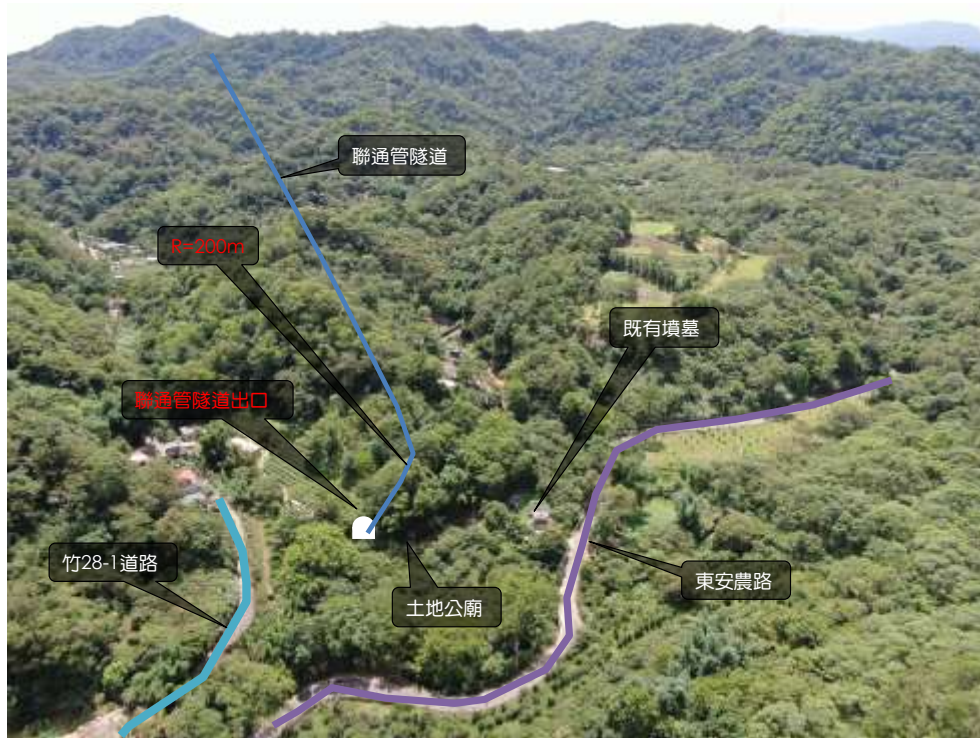
圖 7-11 聯通管隧道出口現況照片
