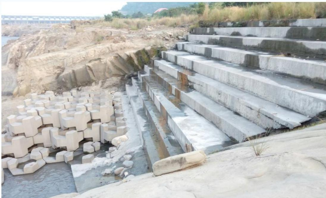
圖 9-1-3 106 年度集集攔河堰設施改善工程-南岸沉砂池 1 號退水路出口保護施工完成照片
