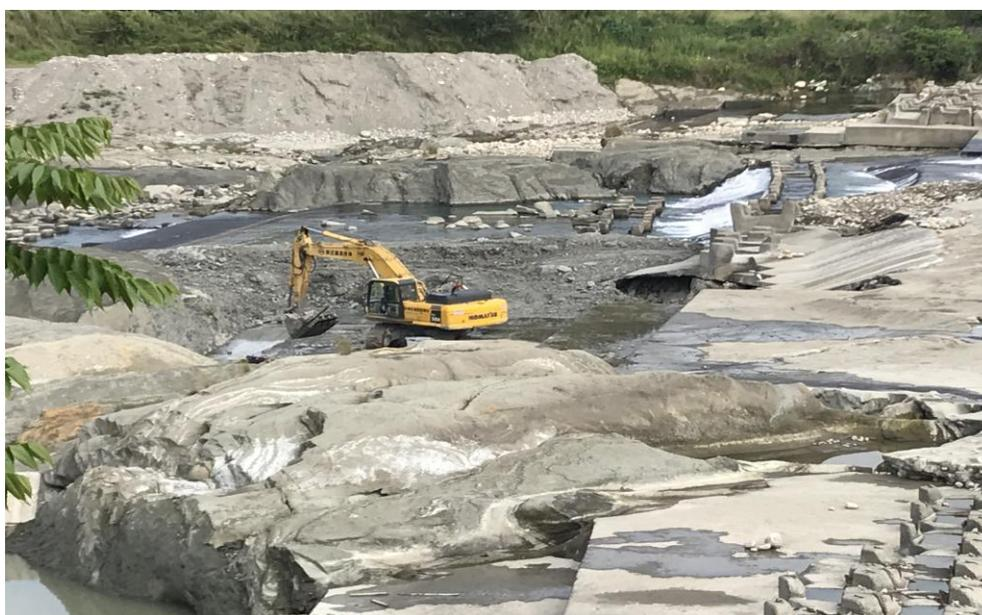
圖 9-1-2 106 年度石岡壩轄區河床沖刷改善工程-河床施工便道照片
