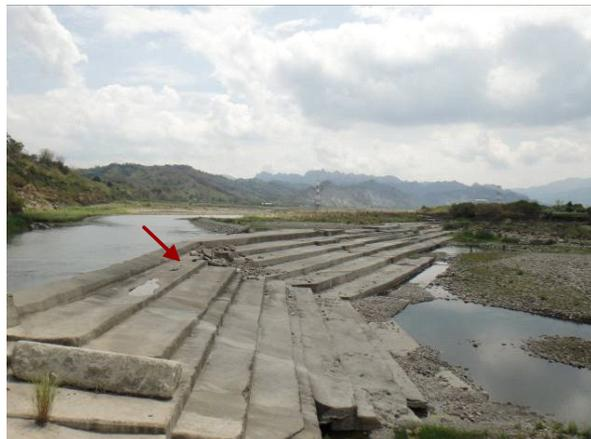
阿罩霧圳固床工右岸護岸毀損、坡腳淘刷。
