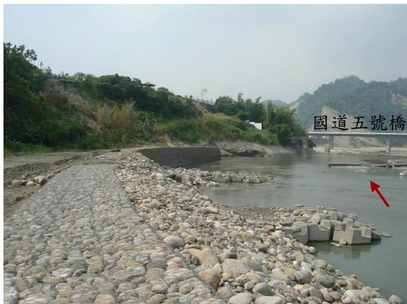
北投新圳取水口前流心偏向左岸，設置丁壩挑流並佈設石籠保護工，防止沖刷加劇。
