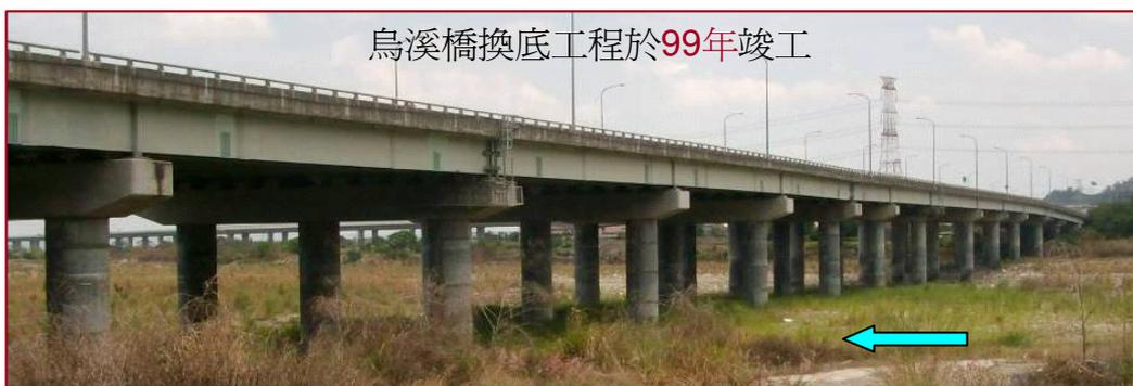
圖 2-4-2 台 3 線烏溪橋 97 年辛樂克颱風後改建情形
