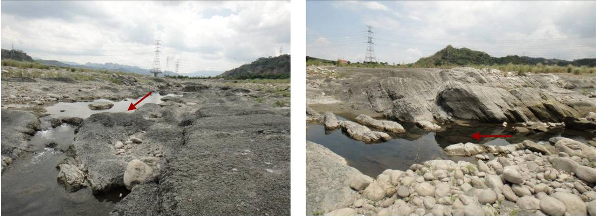
荖荖媽助圳下游護甲層流失、岩盤出露。
