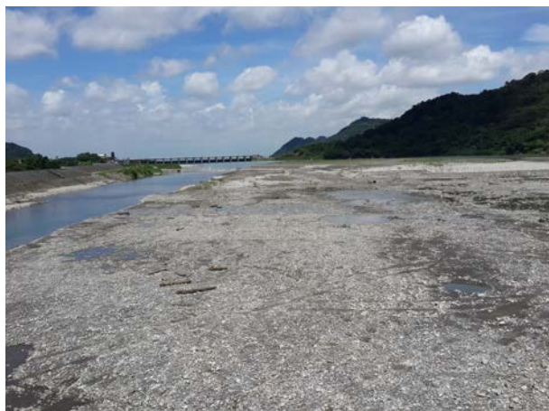
照片 9-2-3 石岡壩清淤挖採開挖後全景
