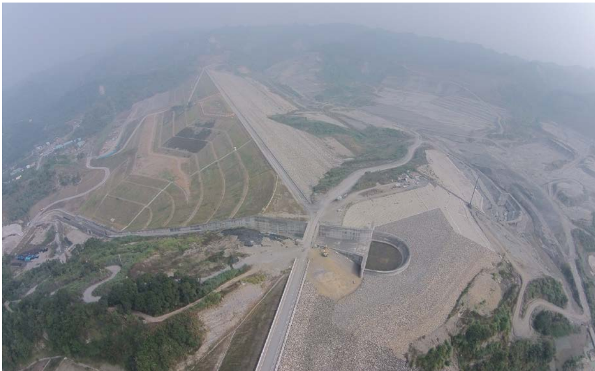
照片 11-2-2 溢洪道及取出水工工區空拍圖
