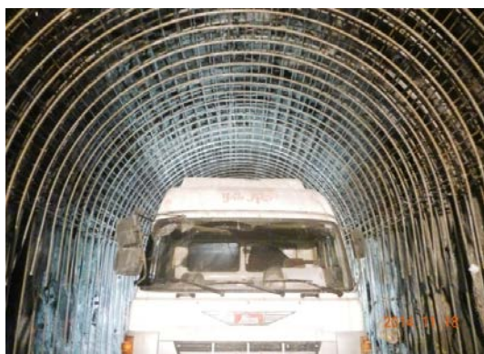
照片 11-2-14 引水隧道鋼筋綁紮情形
