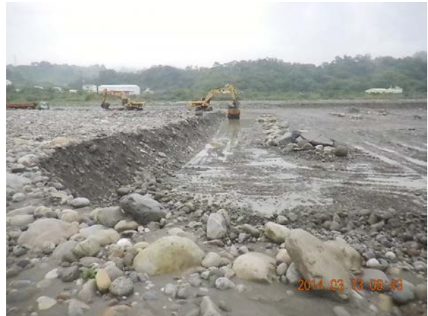
照片 9-2-2 石岡壩清淤挖採執行（二）
