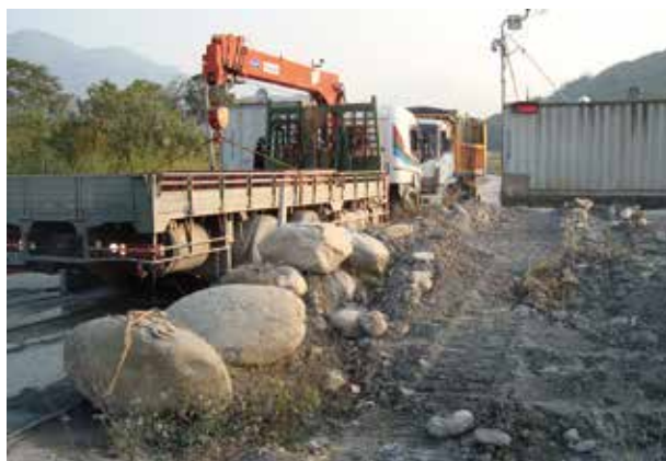
照片 9-2-10 地磅校正作業
