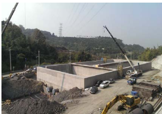
照片 11-2-16 穩壓池施工情形
