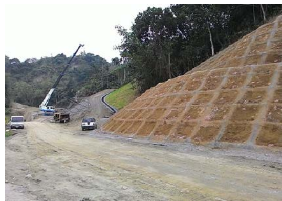
照片 11-2-17 庫區遷建道路施工情形
