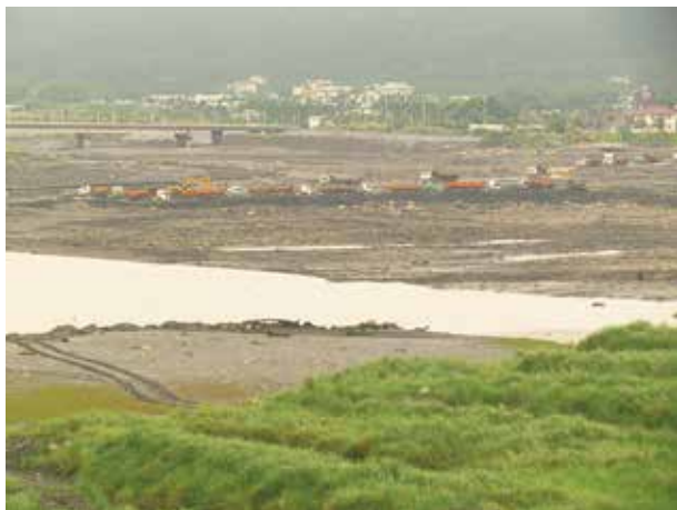
照片 9-2-7 集集堰清淤挖採現場（一）
