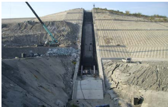
照片 11-2-13 斜依式取水塔施工情形
