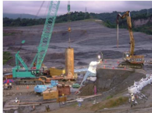
壓入第4節套管及鑽掘
