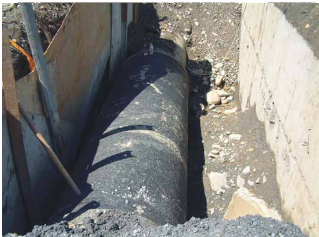
照片 3-2-10 輸水幹管裂管抽換
