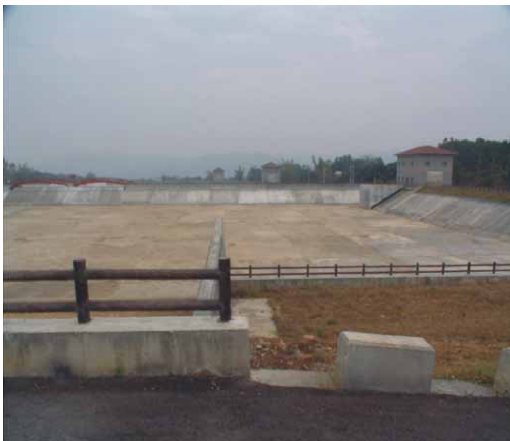
照片3-2-2 第三號貯水池（上池）
