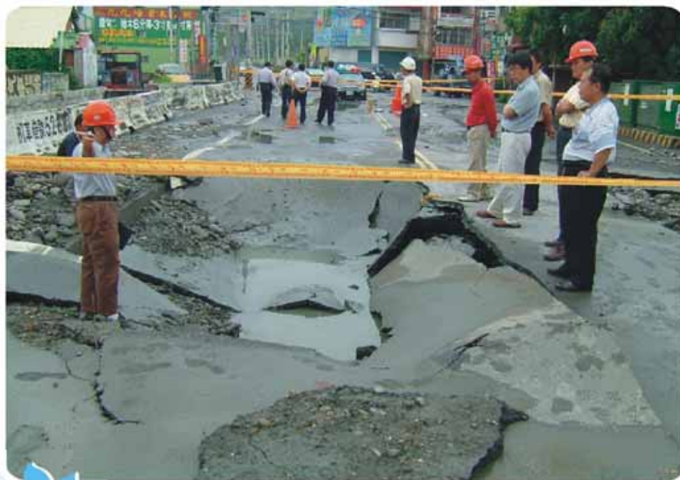
八卦山旱灌輸水幹管試通水發生裂管事件(94.4.28)
