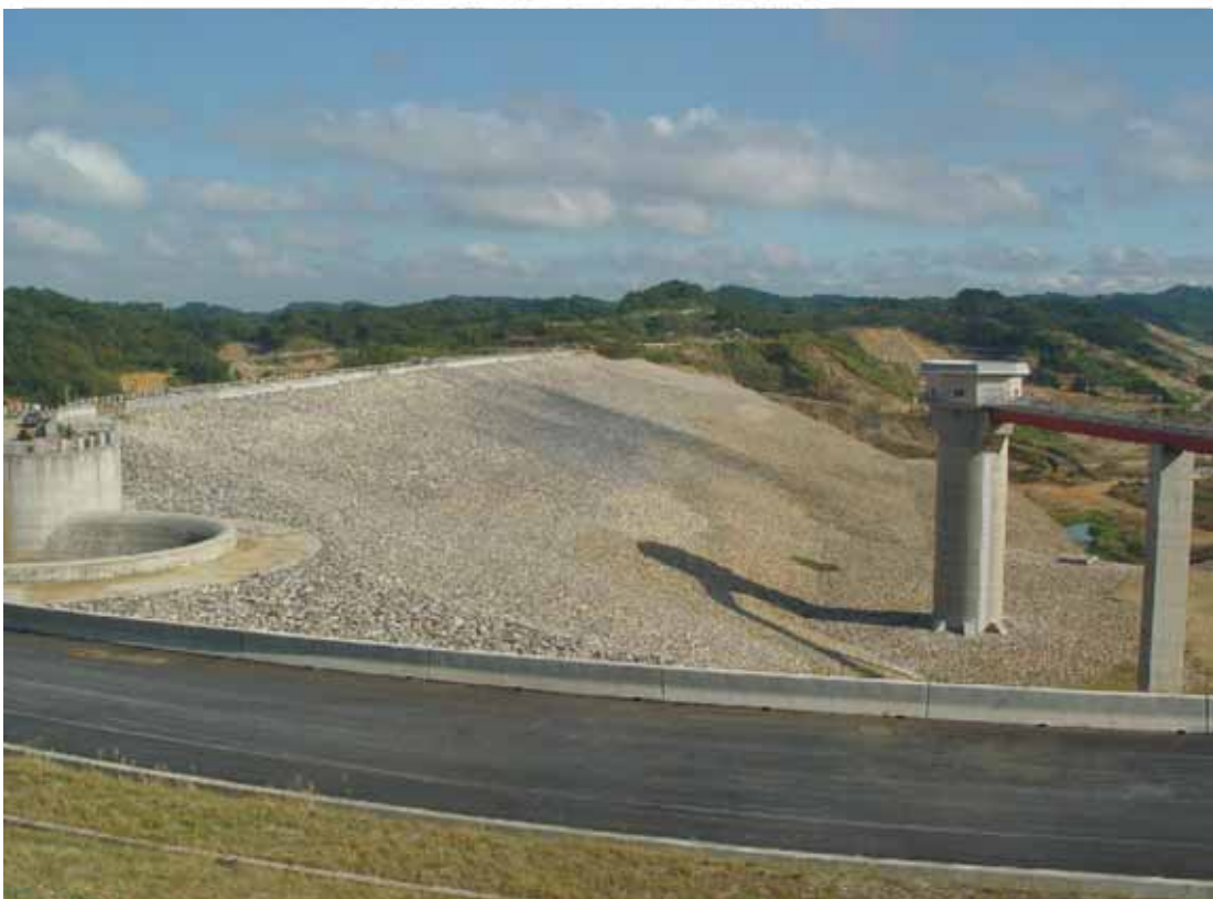
照片 3-1-2 壩坡（上游面）
