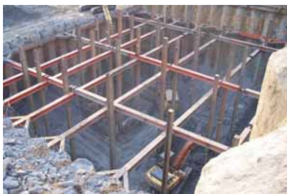
照片3-6-7 廠房降挖(EL.155)
