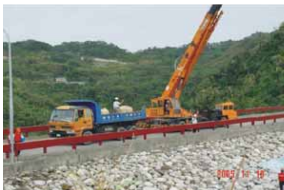
照片9-2-7 防護團工程隊大壩搶險
