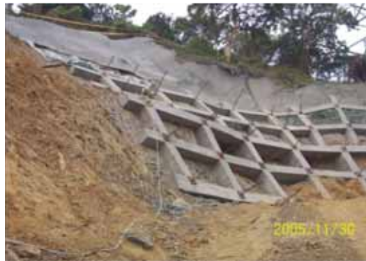
照片3-6-2 豎井上邊坡地錨
