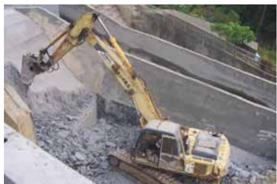
照片3-6-3 現有急流槽底版拆除
