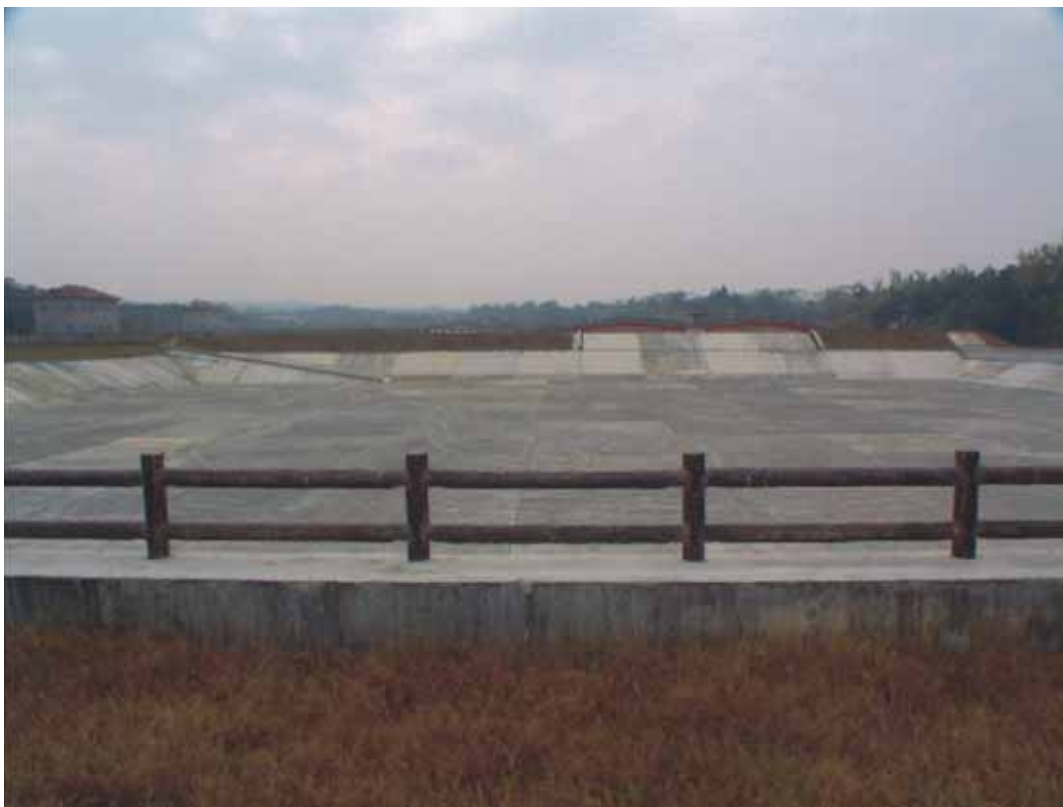
照片 3-2-4 第三號貯水池（下池）
