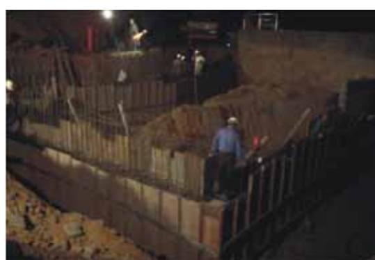
照片3-6-4 進水口繫樑澆置混凝土
