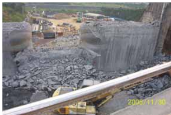
照片3-6-6 平水池溢流堰施工現況
