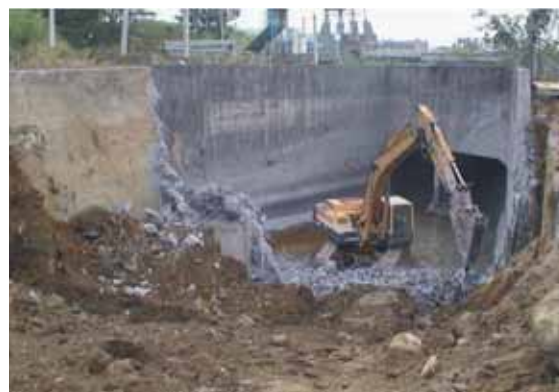
照片3-6-8 尾水路與渠道連接處開挖
