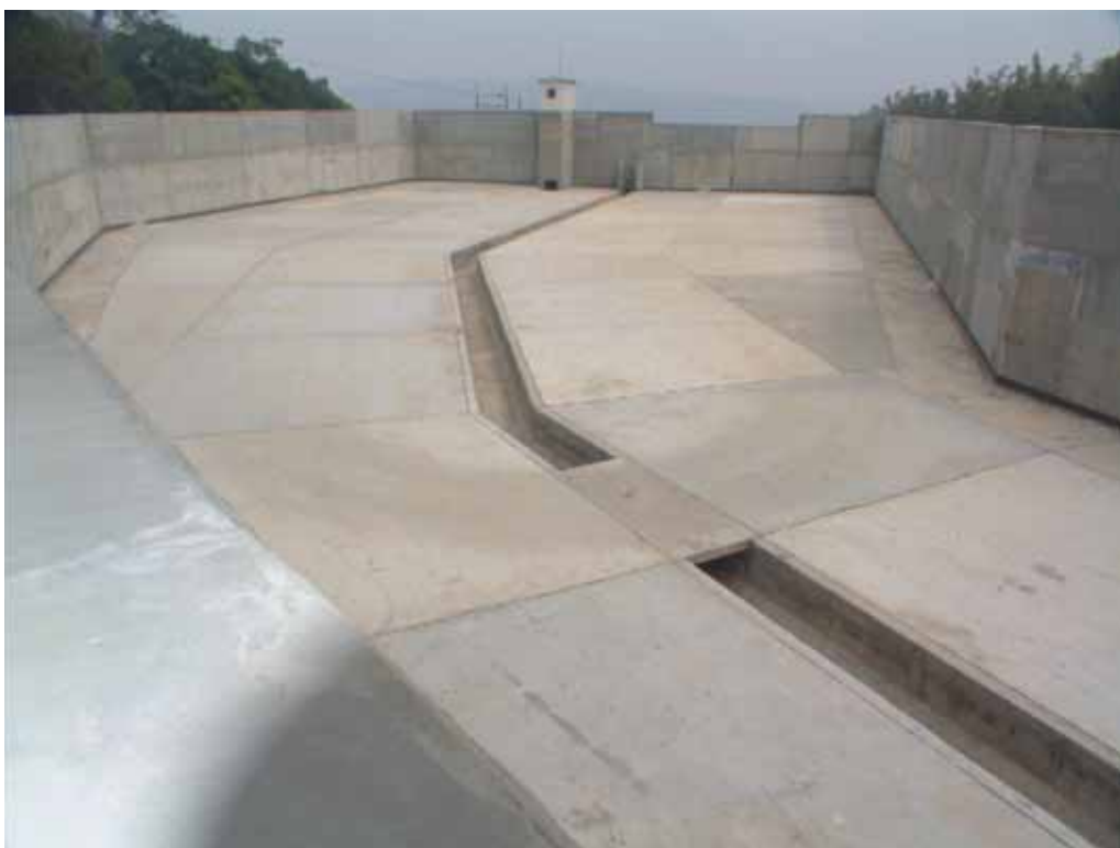
照片 3-2-6 第四號貯水池（下池）
