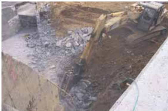
照片3-6-1 現有急流槽側牆敲除現況
