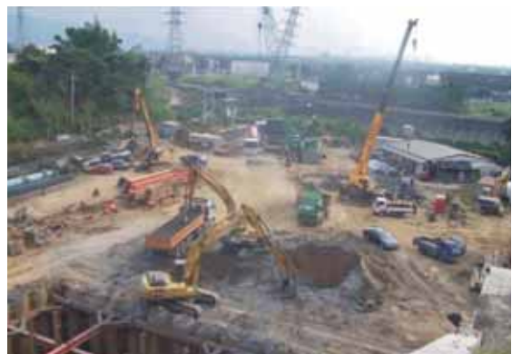
照片3-6-5 尾水路開挖及鑽設排樁
