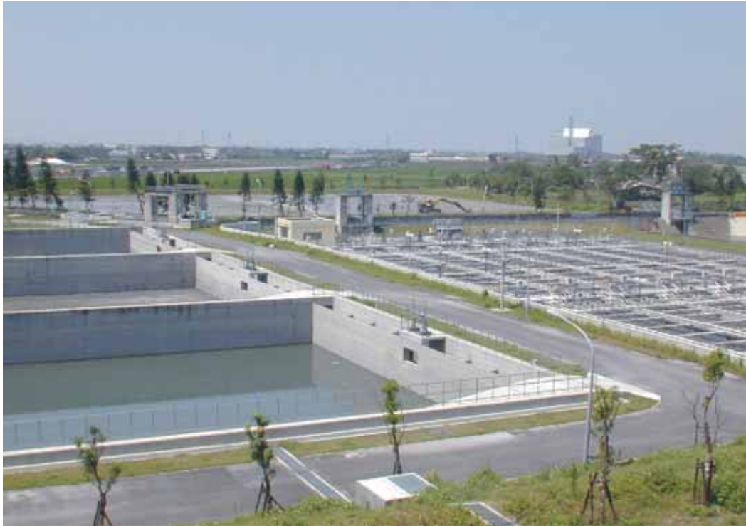
照片 3-2-11 工業用水沉澱池（一）
